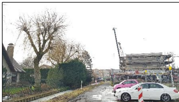
Foto 2: Bomen met holten aan de Kerstanjeburch 24F en nieuwbouw in de achtergrond.
