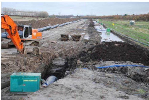
Figuur 3.3 Werkzaamheden in de leidingstraat
