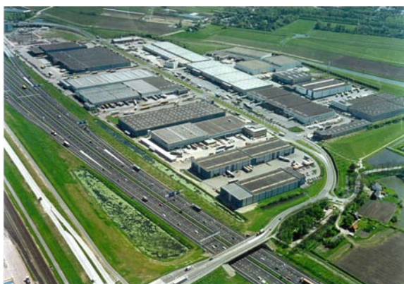
Figuur 4.3 Luchtfoto van het distributiecentrum
