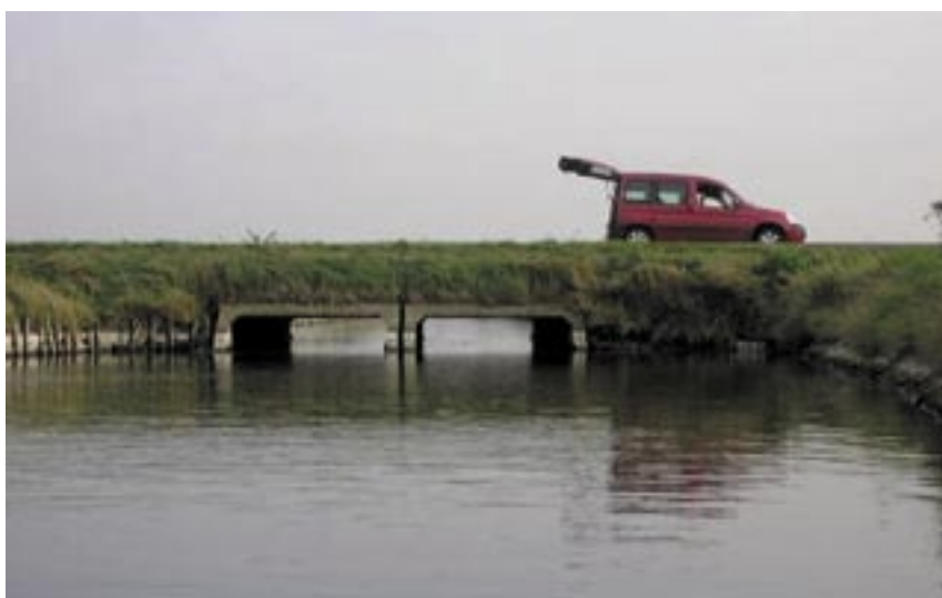
Afbeelding 6.10 voorbeeld van passage van de Duiker, geschikt als onderdoorgang voor vleermuizen.
