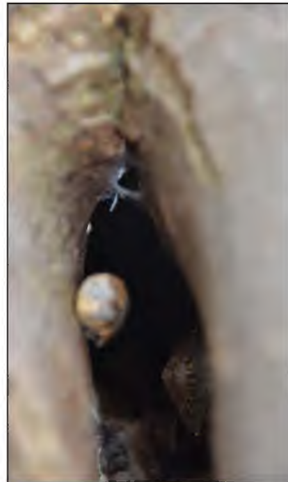
Figuur: de holte is met een zaklamp geïnspecteerd en loopt door naar boven. Dit maakt de holte geschikt als verblijfplaats voor vleermuizen.
