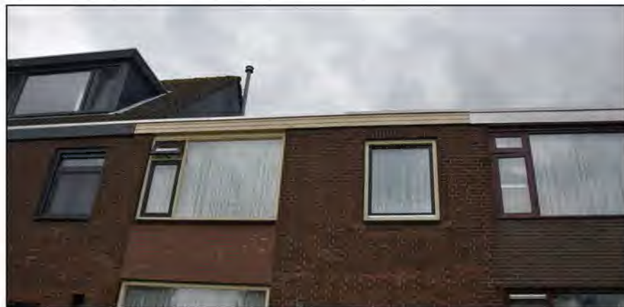
Figuur: de woningen ten zuiden van het plangebied hebben op diverse locaties open stootvoegen. Ook heeft een gedeelte van de bebouwing een opbouw met een pannendak waardoor deze woningen ook geschikt zijn voor huismus en gierzwaluw.
