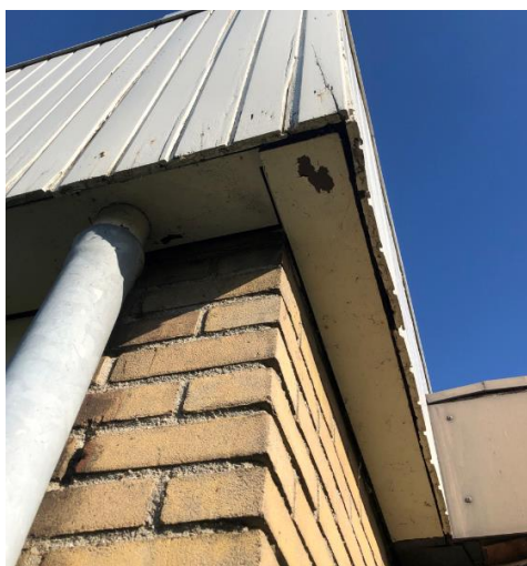
Figuur 13 – potentiële verblijfplaatsen in ruimtes rondom dak van kantinegebouw
