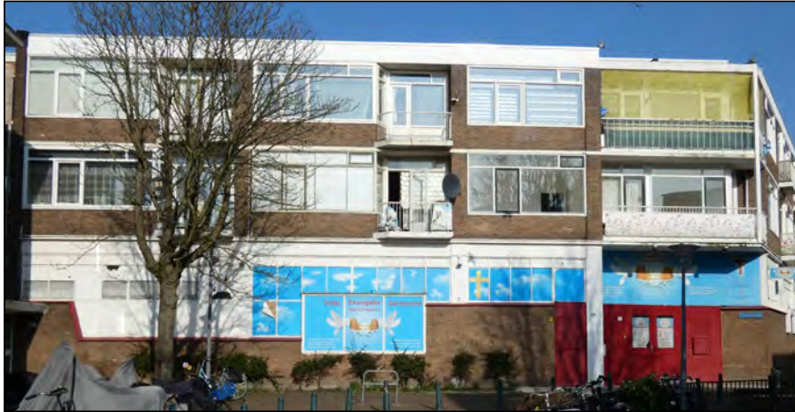
Figuur: Vooraanzicht van de te slopen bebouwing aan de Texelsestraat.
