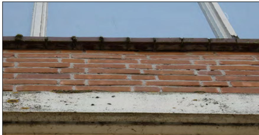
Figuur: Onder de raamkozijnen zijn er geen kieren/ruimtes waar vleermuizen in/achter kunnen kruipen.
