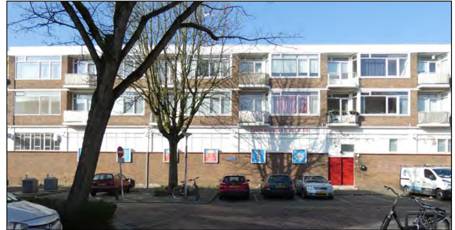
Figuur: Zijaanzicht van de te slopen bebouwing aan de Texelsestraat.
