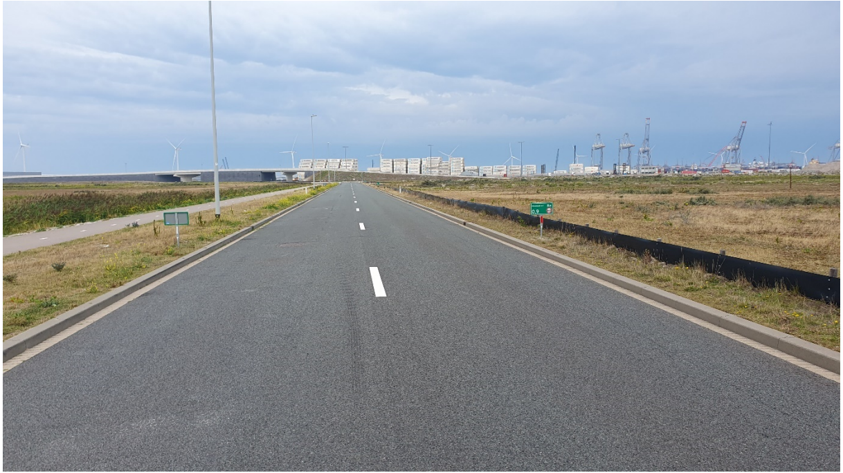
Foto 3 Malakkastraat (kijkrichting westelijk)
