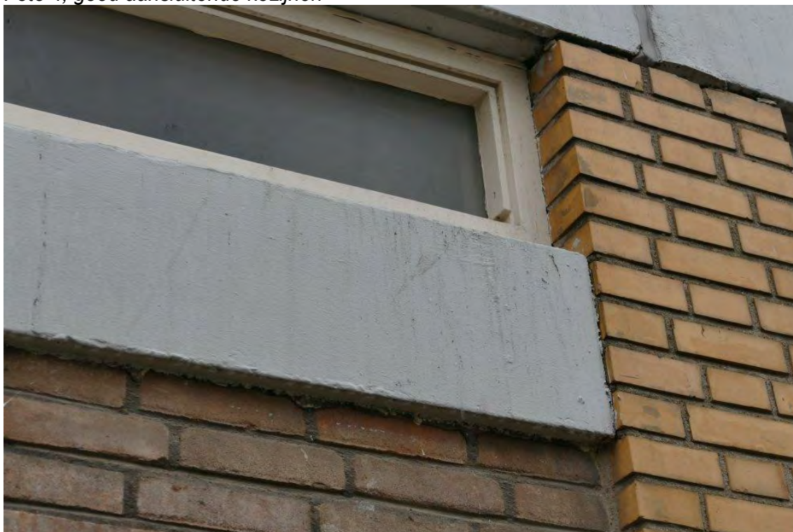
Foto 4, goed aansluitende kozijnen
