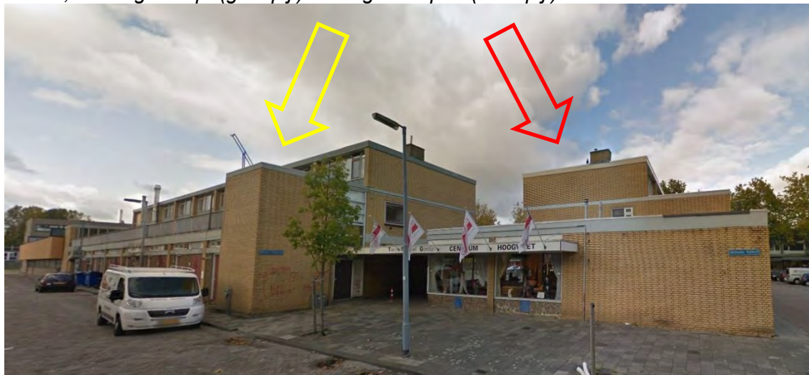
Foto 1, reeds gesloopt (gele pijl) en nog te slopen (rode pijl)
