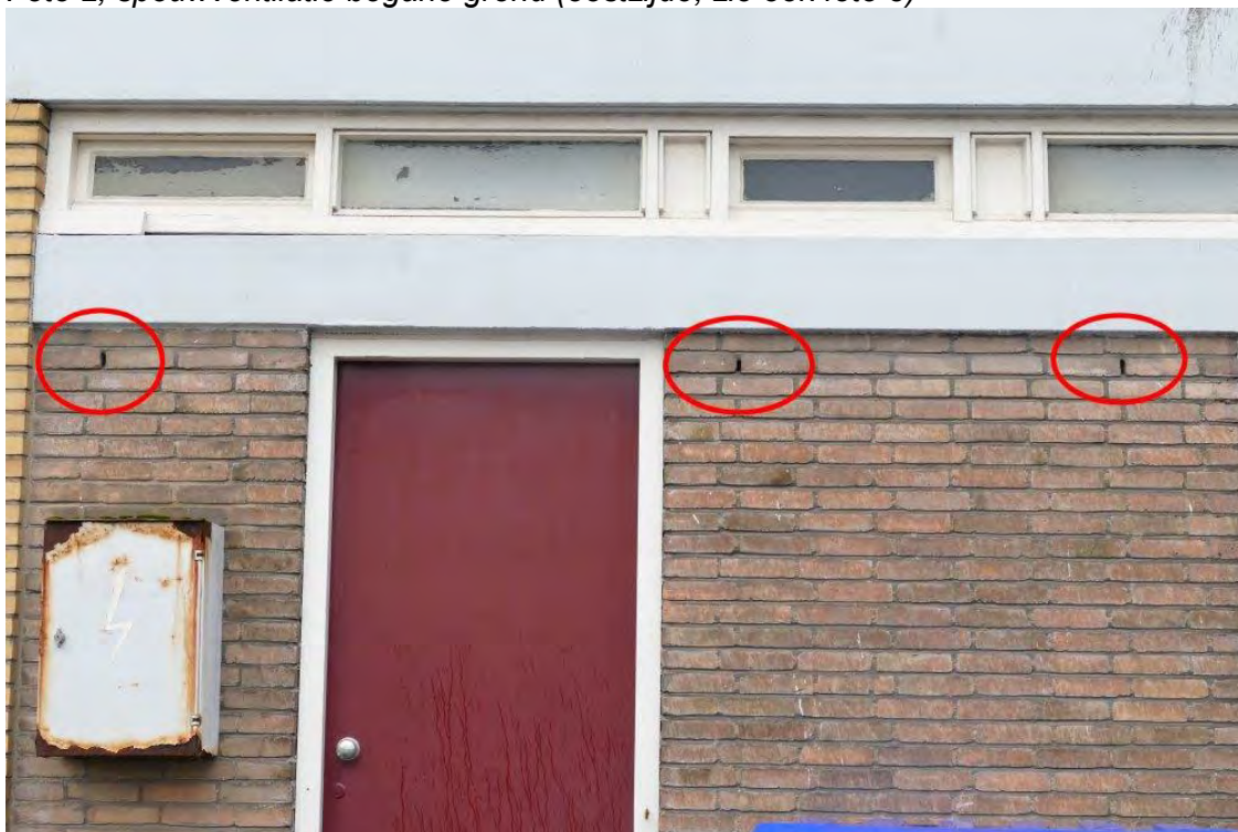
Foto 3, geveldeel met spouwventilatie (rood kader)
