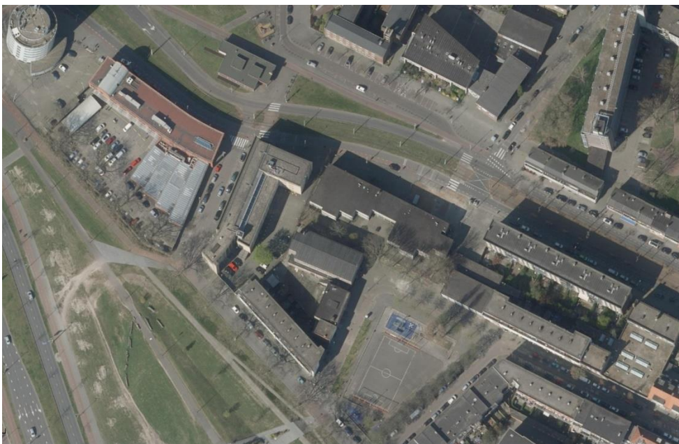
Afbeelding 2.1: Situatie voormalig schoolgebouw aan de Schiedamseweg. Bron: GISweb
