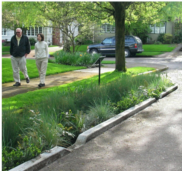
Referentie bioswale voor opvang regenwater
