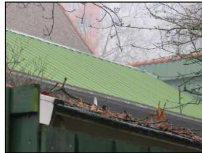
Figuur 8. Zicht op golfplaten dak van buitenzijde, kijkrichting naar het noord-westen.
