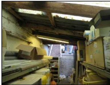
Figuur 7. Aanbouw met dak van asbest golfplaten.
