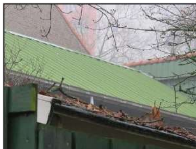
Figuur 2.5 Het dak van de onderzoekslocatie, gezien vanaf de achterzijde.
