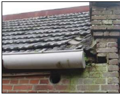
Figuur 10. Dak gezien vanaf de achterzijde, kijkrichting naar het noorden. Zichtbaar is de opening naast de dakgoot op circa 1,5 meter hoogte.
