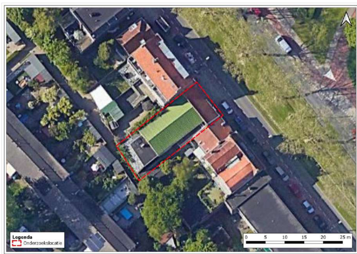
Figuur 2.2 Luchtfoto van de onderzoekslocatie.
