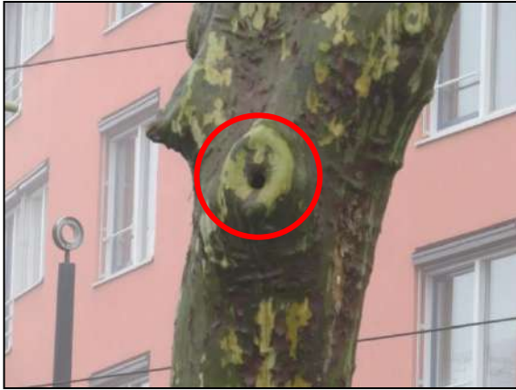
Figuur 12. Plataan aan de Dordtsestraatweg met een holte.
