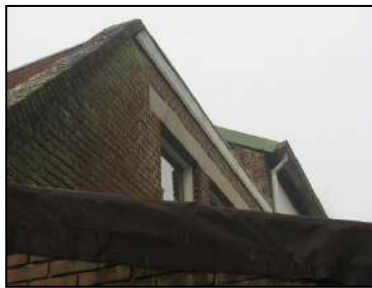
Figuur 15. Andere opening onder daklijst bij betimmerde schuur (nummer 3).
