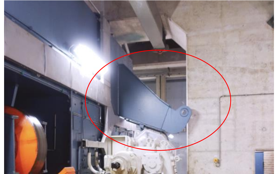
Detail van een van de twee ogen aan de achterzijde van het ballastblok waarmee de klep permanent vastgezet kan worden.
