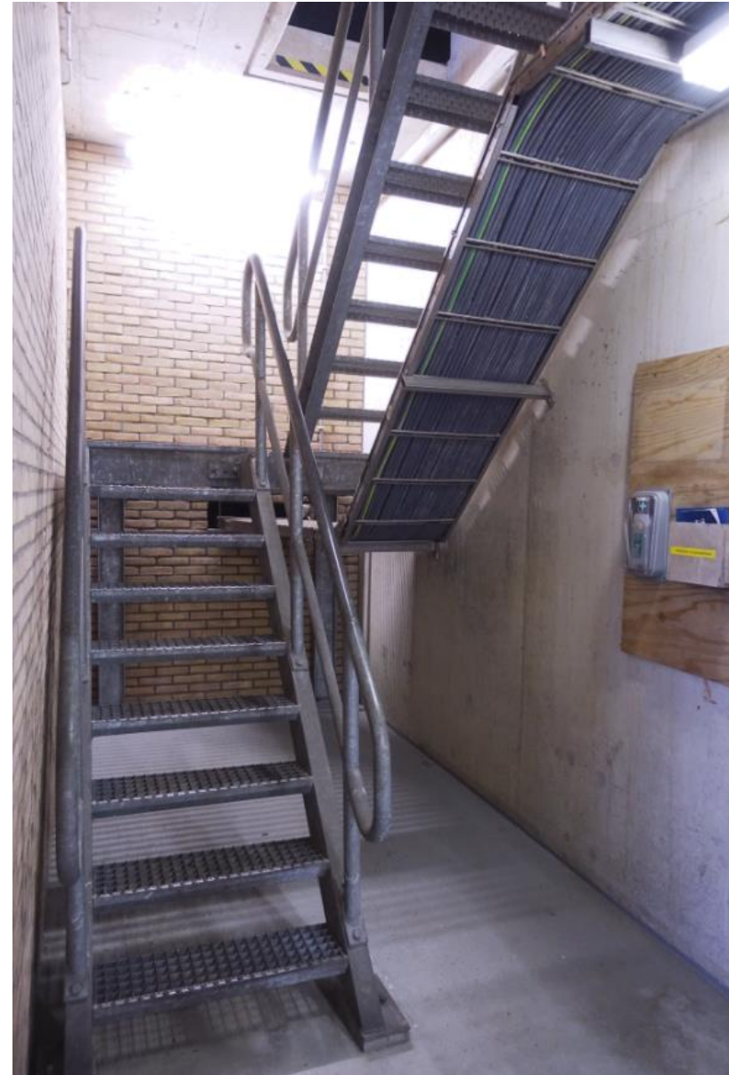
De verschillende niveaus in de pijler zijn via stalen trappen met elkaar verbonden.
