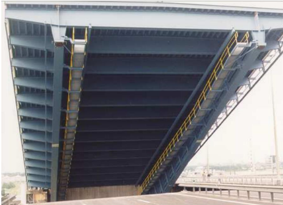
Zicht op de onderzijde van het val met rijdek uit 1998. Afbeelding uit de presentatie: 'Vervanging en Renovatie' van Leo Klatter uit 31 mei 2018 op: kivi.nl.
