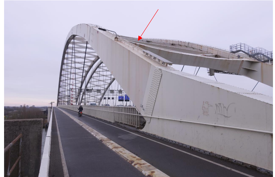
De boog uit 1965 gezien vanaf de noordzijde. Bij de rode pijl is de ladder zichtbaar die toegang geeft tot de trap die langs de binnenzijde van de boog loopt.
