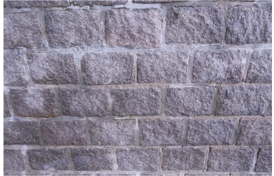
Detail van de granieten bekleding bij de landpijler van de zuidelijke aanbrug uit 1965.
