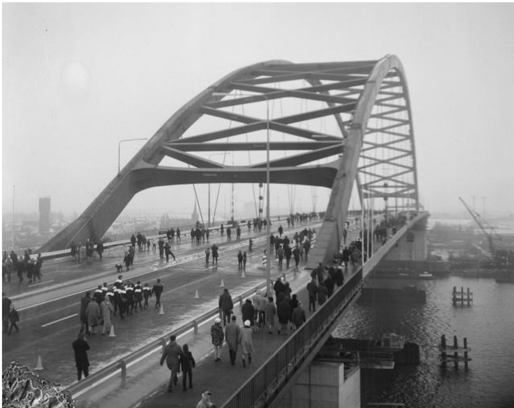
Bij de opening van de brug mochten mensen al wandelend over de nieuwe brug naar de andere zijde van de Nieuwe Maas. Op de voorgrond is het fietspad zichtbaar. Ook de twee funderingen voor de hulpijlers zijn nog niet opgeruimd. NA beeldbank, nr. 917-4116.
