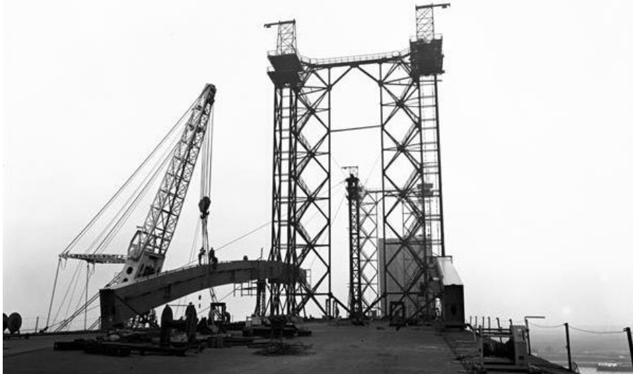
Met behulp van stalen hulppijlers wordt de boog in elkaar gezet. RWS beeldbank, Afdeling Multimedia, nr. 23899-003.
