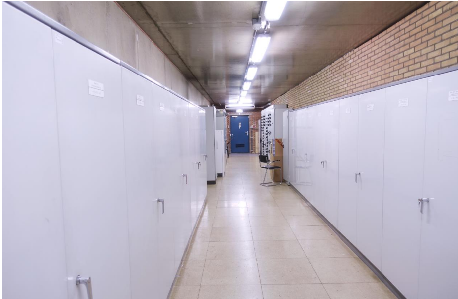
De technische ruimte op de eerste verdieping van de basculepijler uit 1990.
