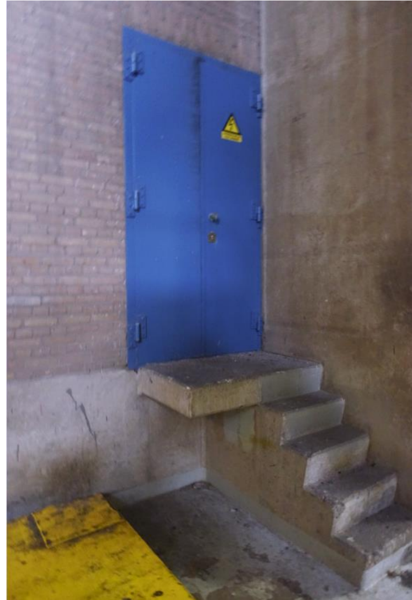
De traforuimte is ondergebracht tussen de twee open ruimtes in de basculepijler uit 1965.
