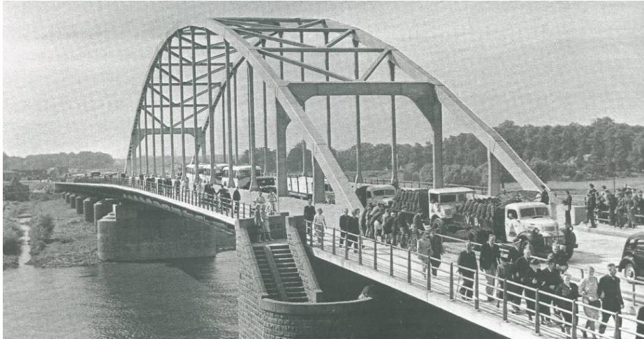
De IJsselbrug in Deventer (1943) was van het type verstijfde staaftoogbrug, dat ook veel is toegepast bij de eerste bruggen over het Amsterdam-Rijnkanaal. Ook deze brug heeft fietspaden aan de buitenkant, zoals gebruikelijk in die periode. Het bovenwindverband bestaat hier uit een K-verband. Uit: Bruggen in Nederland 1800-1940 Vaste bruggen van ijzer en staal , (1997)
