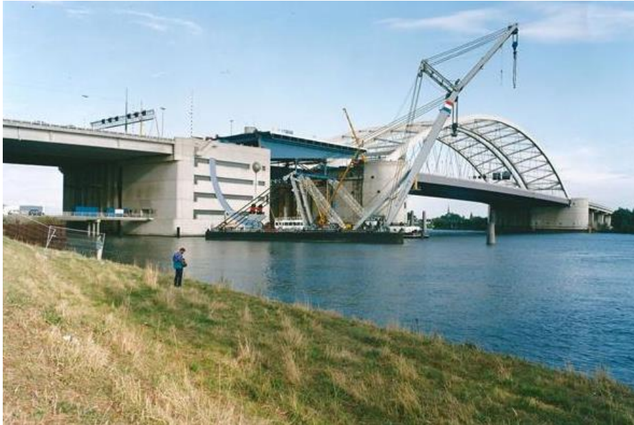
Vervanging van het val in 1998. Vanaf deze zijde van de oever is ook goed het kunstwerk zichtbaar tegen de westgevel van de basculepijler uit 1990. RWS beeldbank, nr. A16-1998-015.
