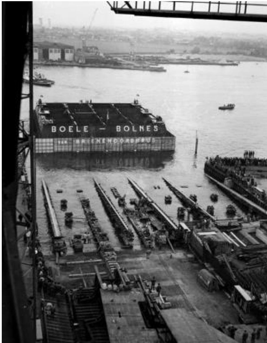
De tewaterlating van de fundering van de basculepijler bij de werf van Boele Bolnes in Ridderkerk. RWS beeldbank, Afdeling Multimedia, nr. 23859-008.
