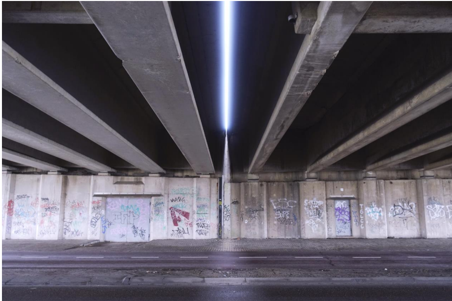
Aan de noordzijde is het landhoofd uit 1990 iets hoger dan dat uit 1965.
