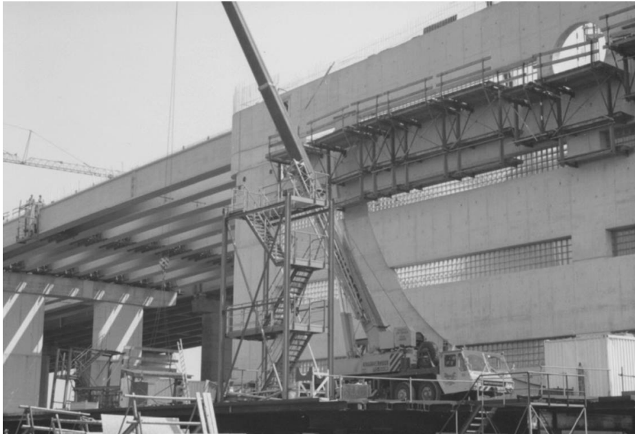
De bouw van de basculepijler gezien richting de aansluiting met de eerste noordelijke aanbrug. SAR beeldbank, nr. 4100_1989-3051, fotograaf: P. van der Ree.
