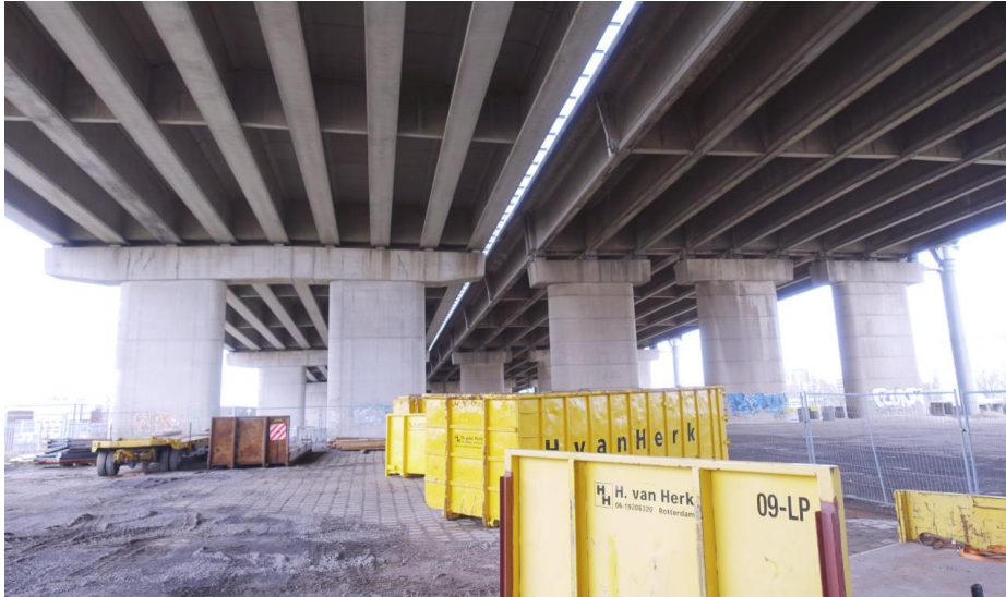
Zicht op de liggers van de noordelijke aanbruggen met links het rijdek uit 1990 en rechts dat uit 1965.
