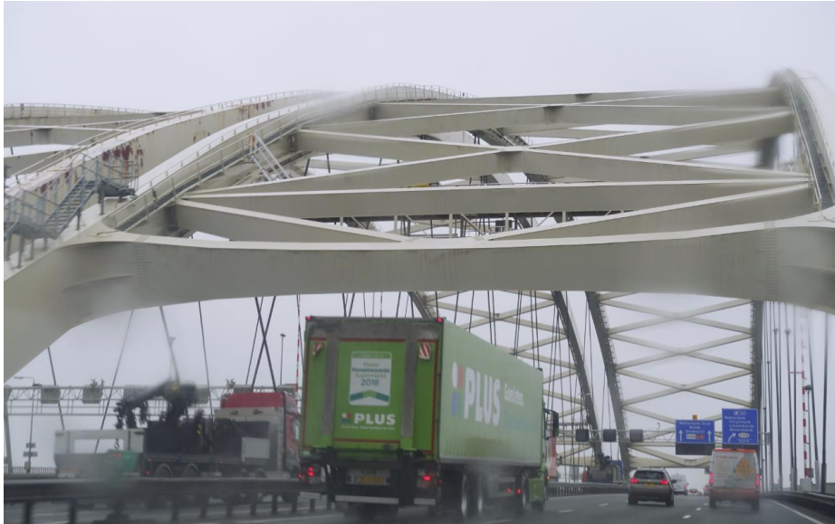
Zicht op het eindportaal in K-verband van de brug uit 1990.
