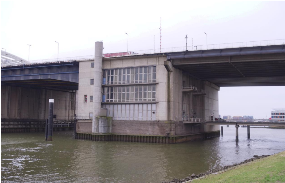
De basculepijlers staan geheel in het water, zoals hier gezien richting het westen.
