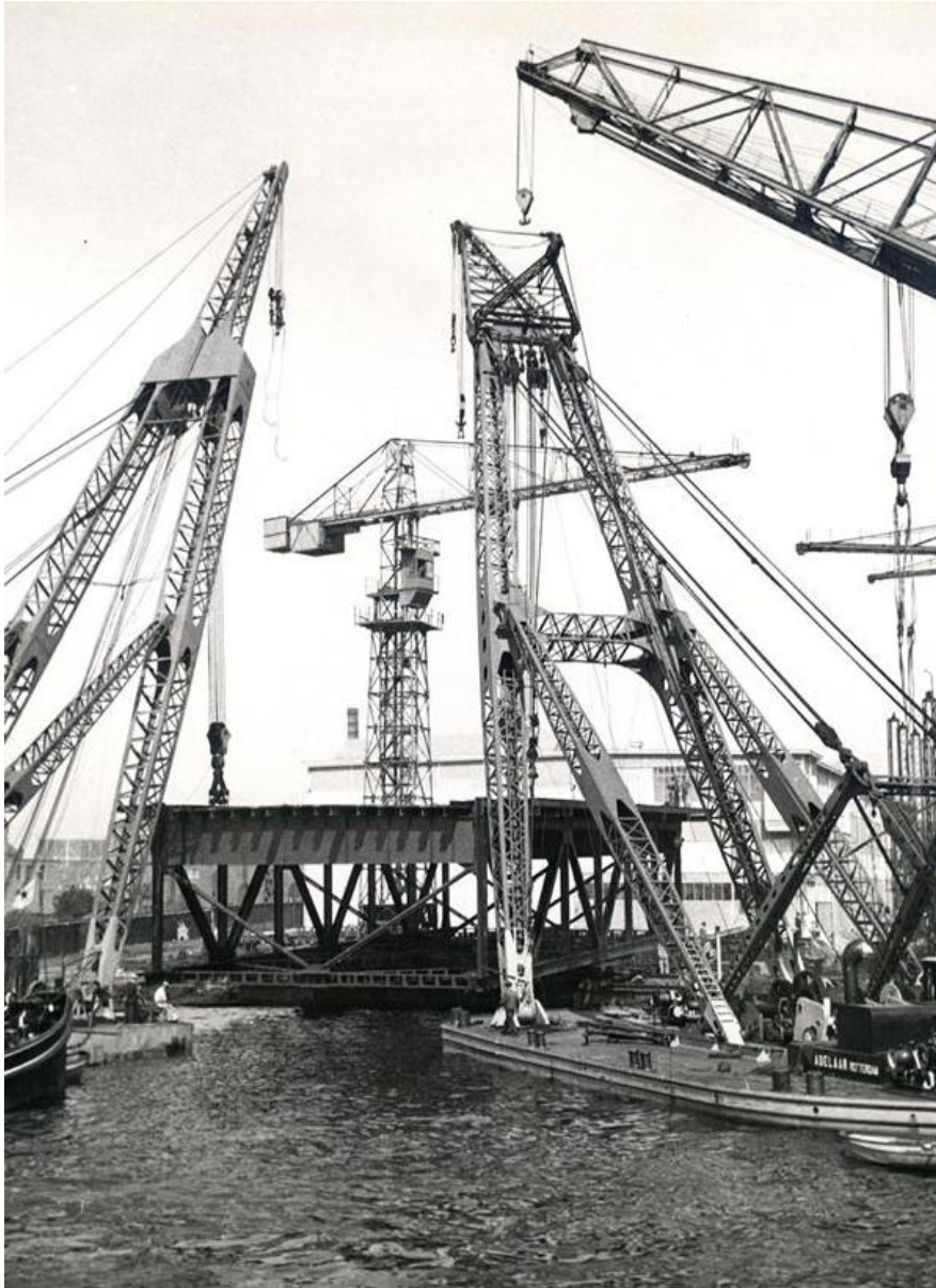
De plaatsing van het val in 1939 bij de brug over de Noord bij Alblasterdam geschiedde met veel drijvende kranen. RWS beeldbank, Afdeling Multimedia.
