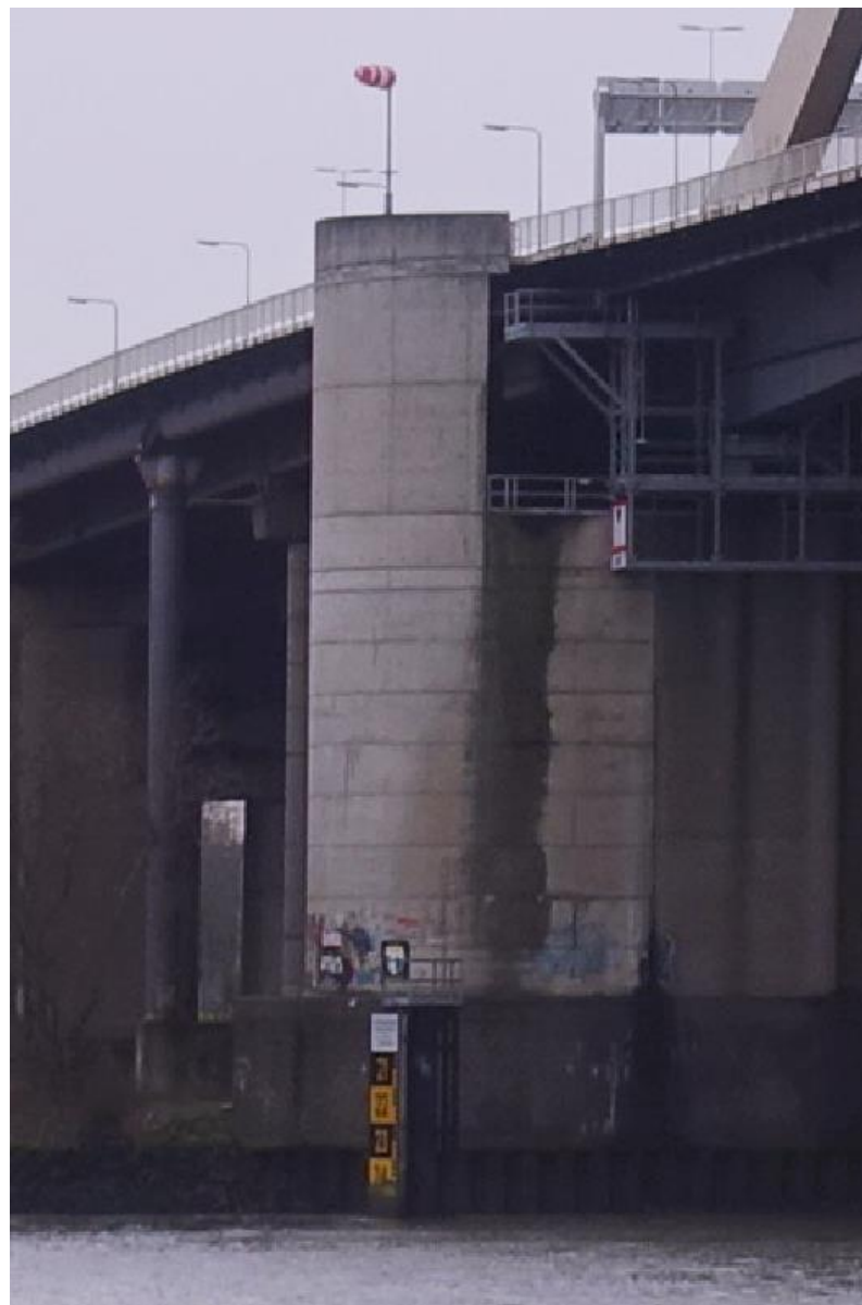
De zuidelijke pijler heeft ook een latere betonnen uitbouw. Deze pijler is overigens niet uitgebreid en bezit nog de oorspronkelijke vorm.
