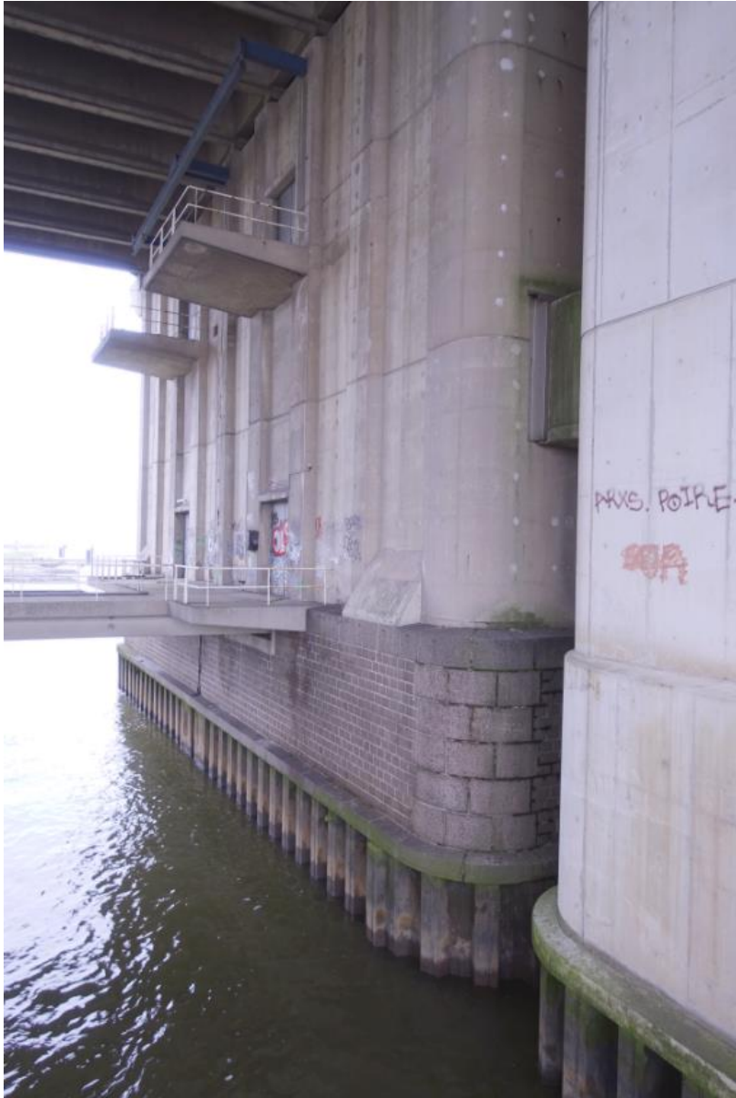
De opbouw van de basculepijler uit 1965 gezien vanaf de brug naar de pijler uit 1990.
