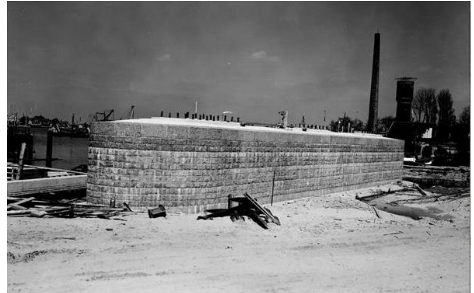
Constructie van een pijler van de zuidelijke aanbrug in 1961. RWS beeldbank, Afdeling Multimedia, nr. 23863-003.
