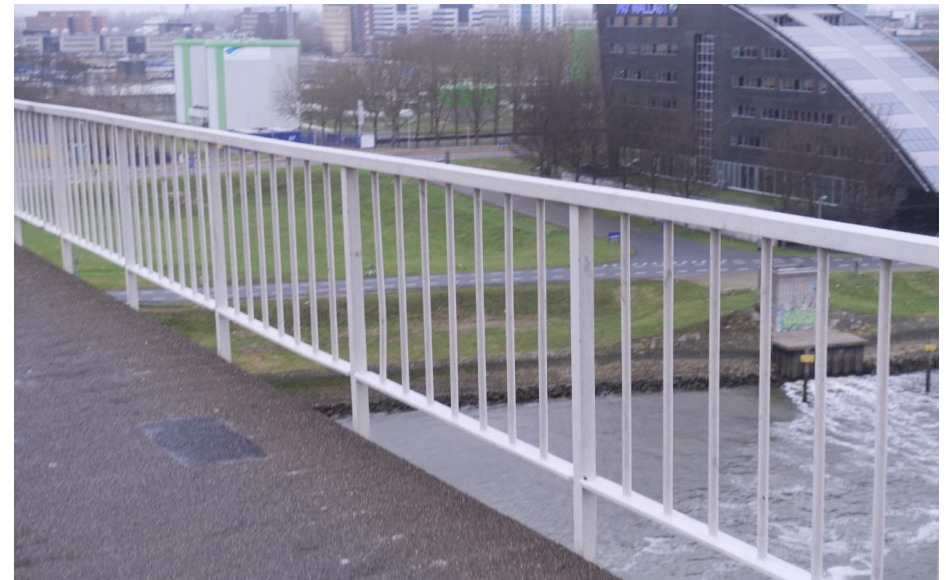
De leuning uit 1965 bij het fietspad aan de zijde van de rivier.
