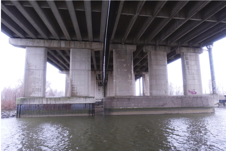
Zicht op de rivierpijler van de zuidelijke aanbrug met links de opbouw uit 1990 en rechts uit 1965.
