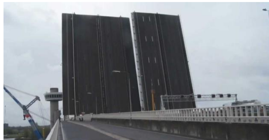
Afbeelding van de twee basculebruggen in open toestand. Goed zichtbaar is de iets langere afmeting van de nieuwe klep en de bredere afmeting van de twee oude kleppen. Deze bredere afmeting komt door de aanwezigheid van het fietspad aan de oostzijde van de brug. Still uit de youtube video 'Van Brienenoordbrug', 11 april 2012, gepubliceerd door Robin221992.
