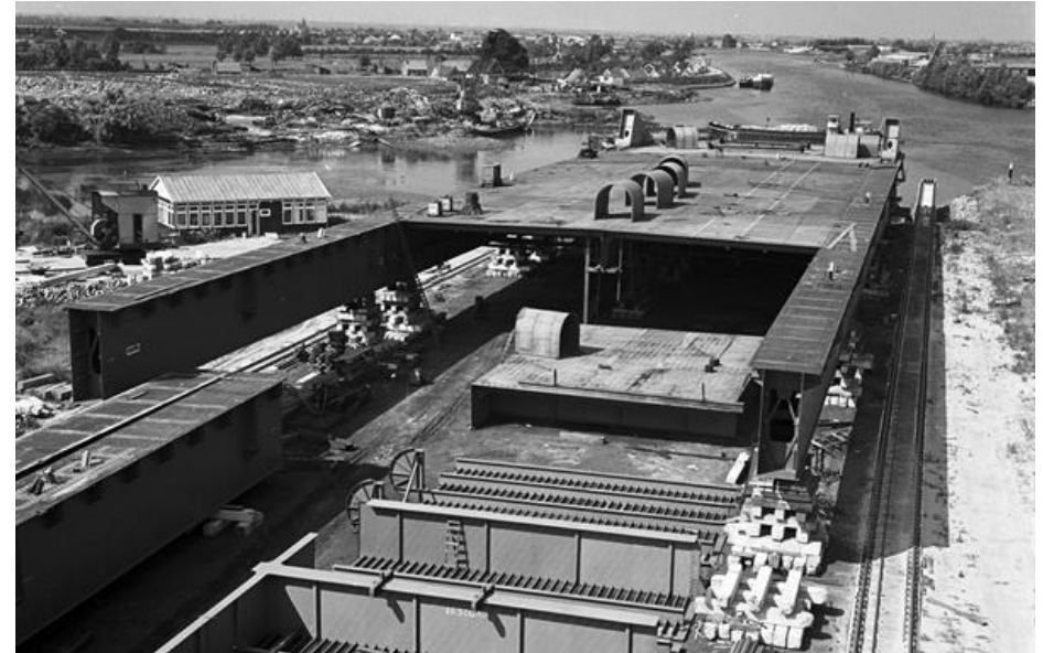
Zicht op de werkplaats naast de bouwplaats van de brug waar de verschillende onderdelen werden samengevoegd, zoals hier de hoofdliggers van de overspanning met stalen rijdek.
