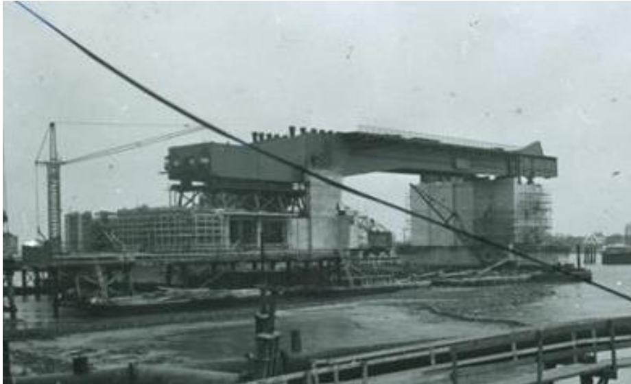
De basculepijler is in opbouw terwijl er al een val is ingehesen. RWS beeldbank, Auke Leen, nr. BOB-071.
