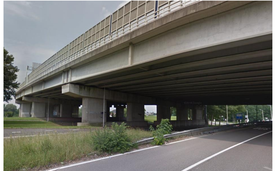
Aan de zuidzijde zijn twee naast elkaar gesitueerde doorgangen die onderdeel zijn van de aanleg van de brug in 1965. Google Maps 2018.
