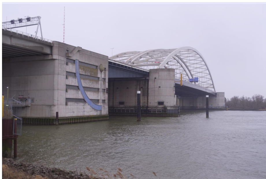
De westelijke brug uit 1990 gezien vanaf de noordoever.
