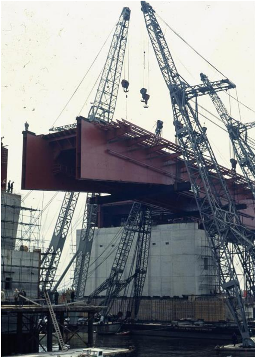
Het inhijzen van het voorste deel van een van de twee vallen bij het basculedeed. Aan de zijkant van de hoofdligger zijn de stalen consoles en het rijdek van het fietspad zichtbaar. RWS beeldbank, Auke Leen, nr. BOB-082.
