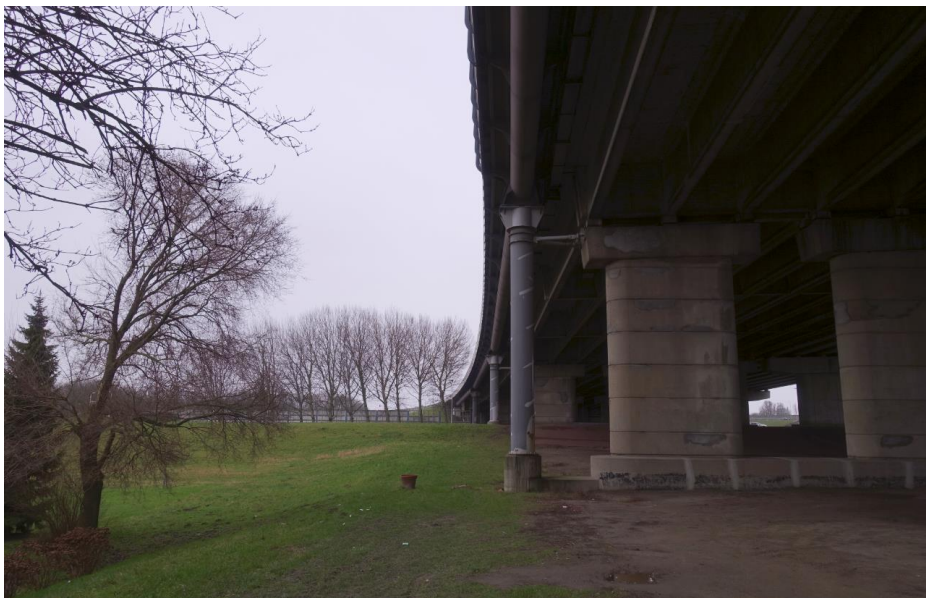
De oostelijke aanbrug op de zuidoever gezien richting het zuiden.
