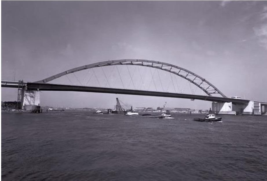
Zicht vanaf het water op de Van Brienenoordbrug over de Nieuwe Maas in 1965. RWS beeldbank, Afdeling Multimedia, nr. 23914-001.
