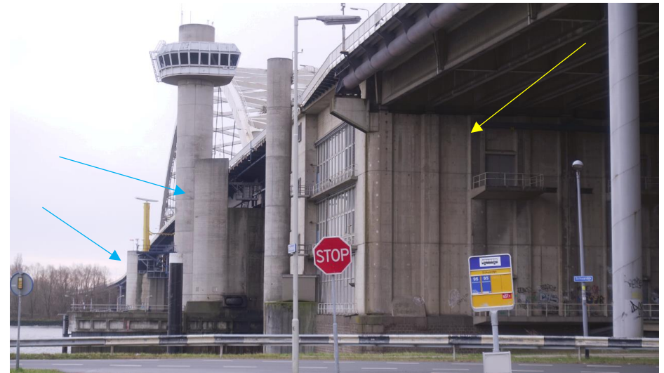
Zicht op de oostzijde van de Van Brienoordbrug uit 1965, met het basculedeel (gele pijl) en de twee rivierpijlers van de boogbrug (blauwe pijl).
