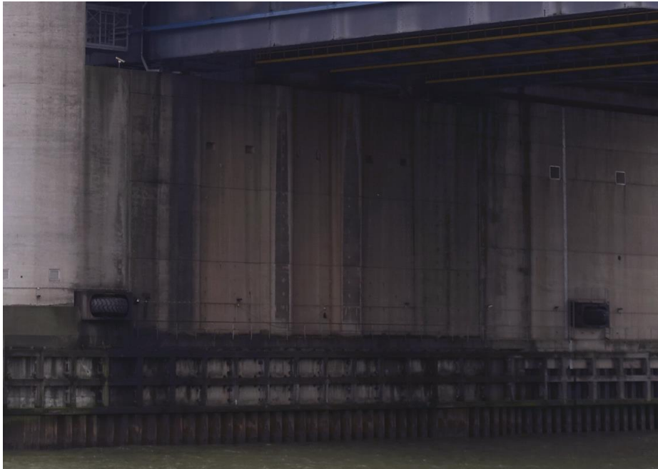
Detail van de gevel van de noordelijke rivierpijler van de boogbrug uit 1965 die is uitgevoerd met verdiepte vlakken.
