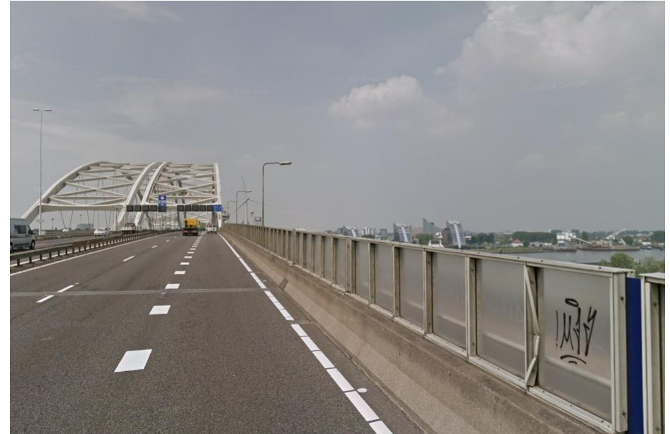
Aan de oostzijde van de brug is na 1990 ter hoogte van de aanbrug een geluidsscherm tussen snelweg en fietspad gemaakt. Google Maps 2018.
