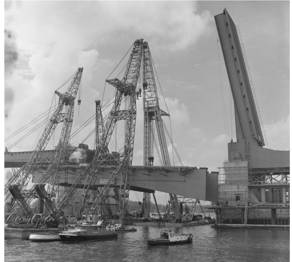
Het inhijzen van het voorste deel van het tweede val bij de basculebrug op 22 mei 1963. NA beeldbank, nr. 915-1859.
