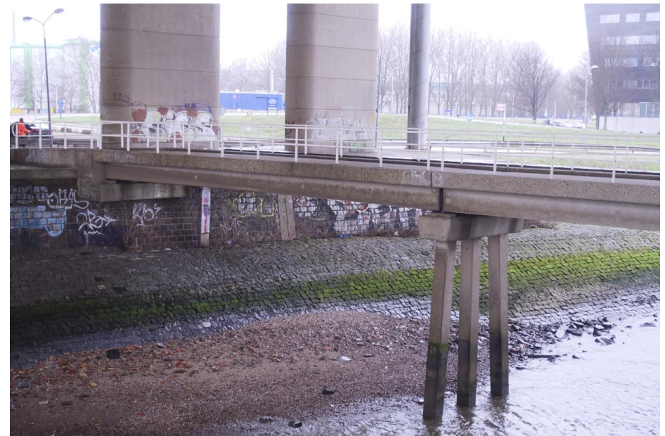
De betonnen brug uit 1965 die toegang geeft tot de oostelijke basculepijler.
