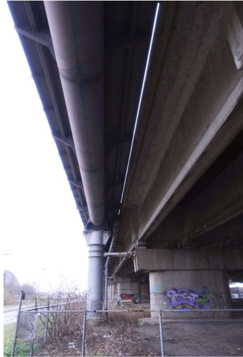
Het in 1990 vervangen fietspad aan de oostzijde van de brug.
