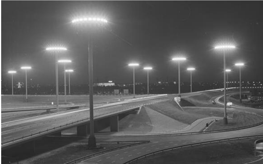
Detail van de verlichting bij het knooppunt aan de zuidzijde van de brug. RWS beeldbank, Afdeling Multimedia, nr. Rws_10715.
