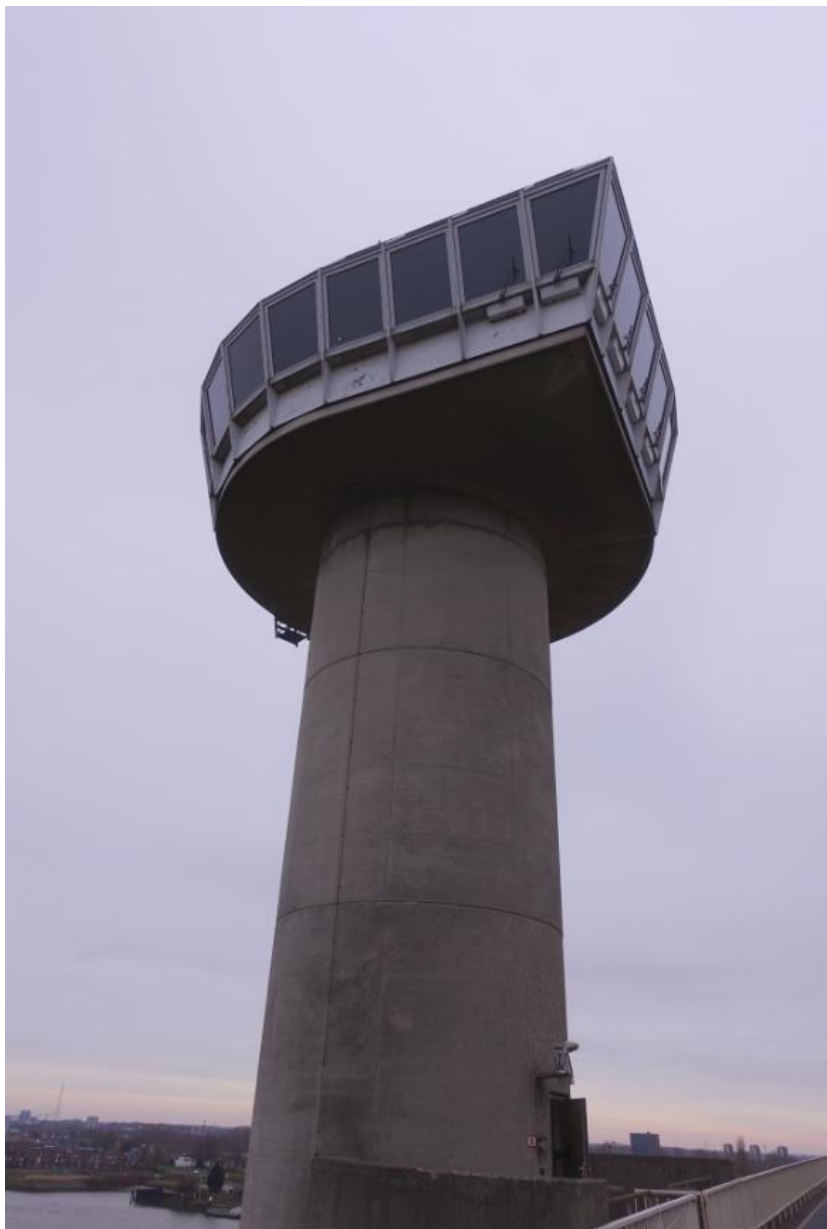
Zicht op de bovenzijde van de betonnen koker uit 1987 met het bedieningshuis.
