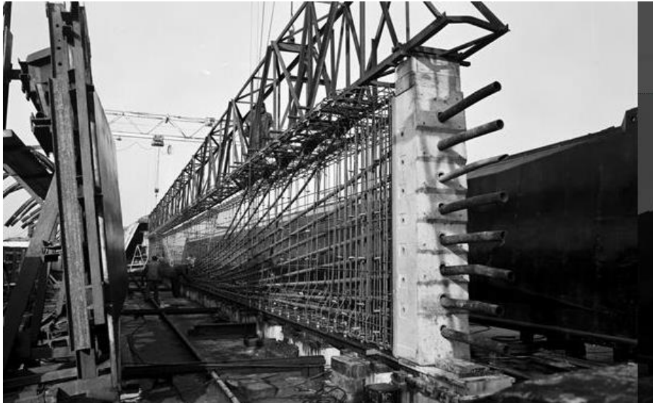
Zicht op een langsligger in voorgespannen beton van een van de aanbruggen. RWS beeldbank, Afdeling Multimedia, nr. 23897-005.
