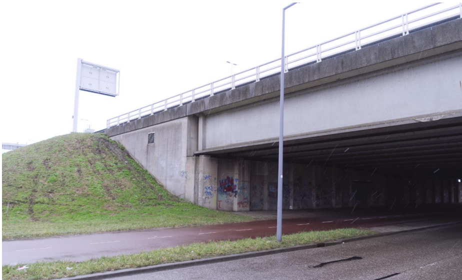
Zicht op het talud en landhoofd uit 1990 aan de noordzijde van de brug.
