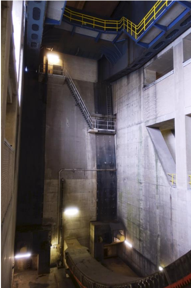
Zicht op een van de twee grote open ruimtes in de basculepijler uit 1965, gezien richting het zuiden.
