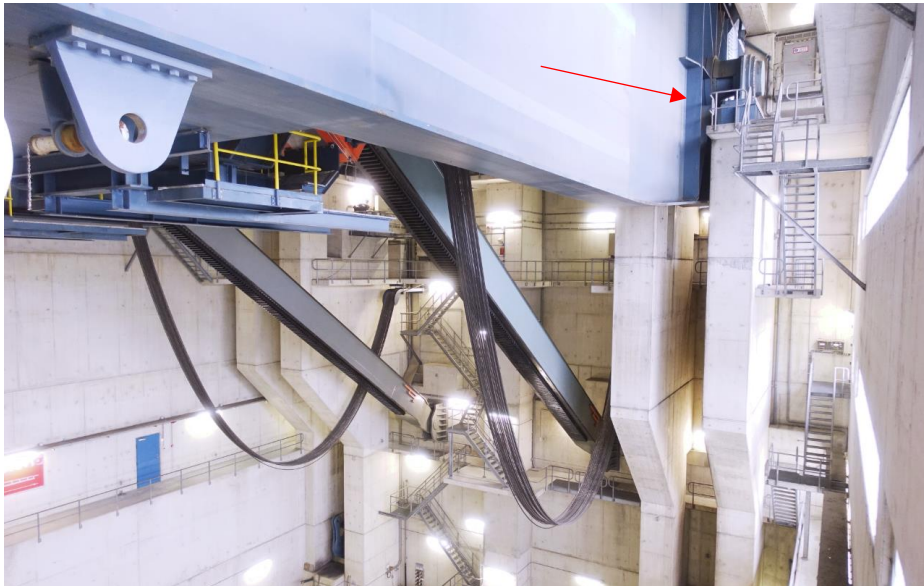
De buitenzijde van de hoofdligger gezien bij de aansluiting met de draaia's (pijl).
