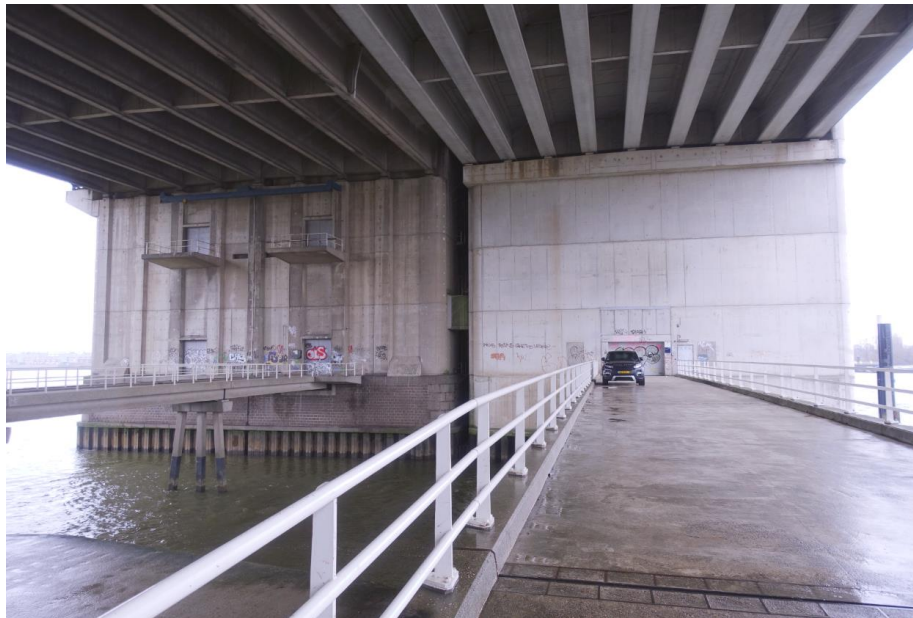
De toegang tot de basculepijler uit 1990 kan worden bereikt via een betonnen brug.
