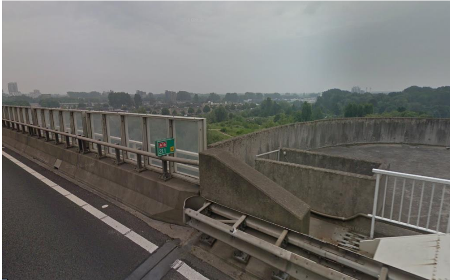
Bij de overgang van boogbrug naar aanbrug is aan de westzijde een geluidsscherm met glazen vulling gemaakt. Google Maps 2018.
