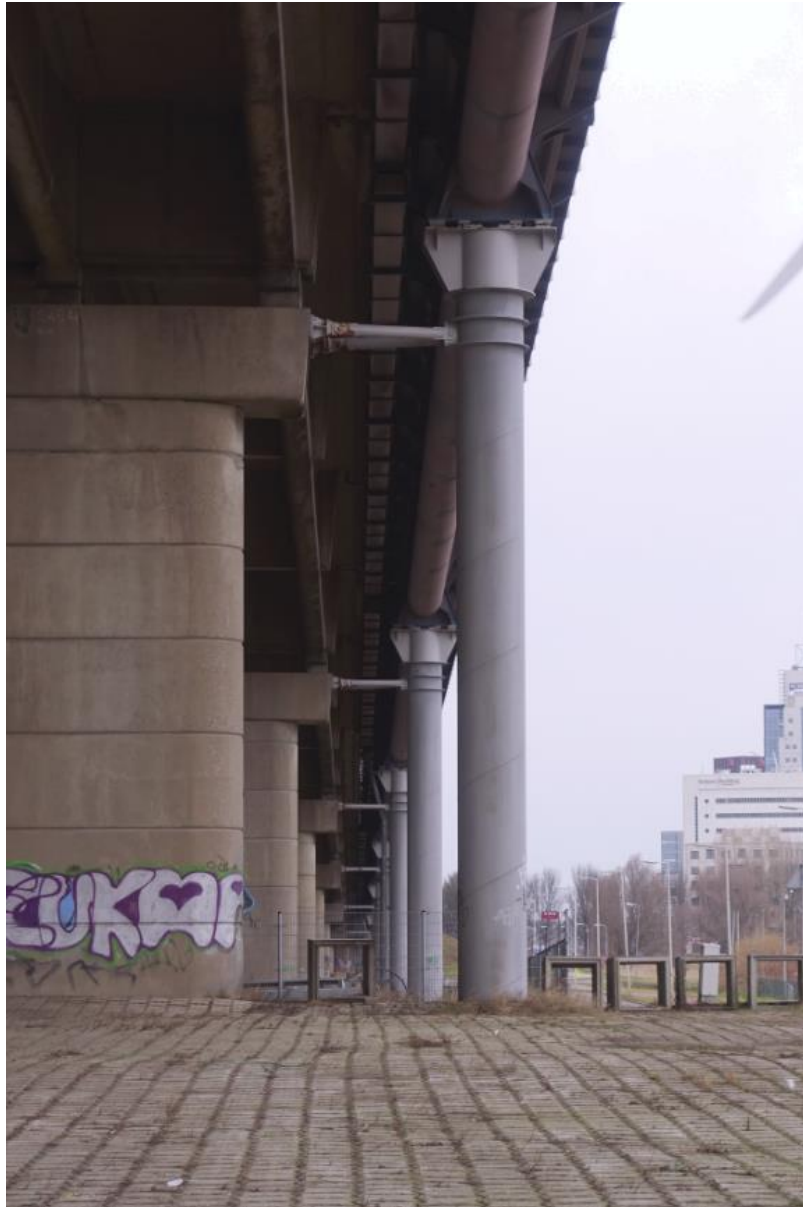
Het fietspad aan de oostzijde van de brug is in 1990 vervangen door een nieuwe variant op stalen kolommen.
