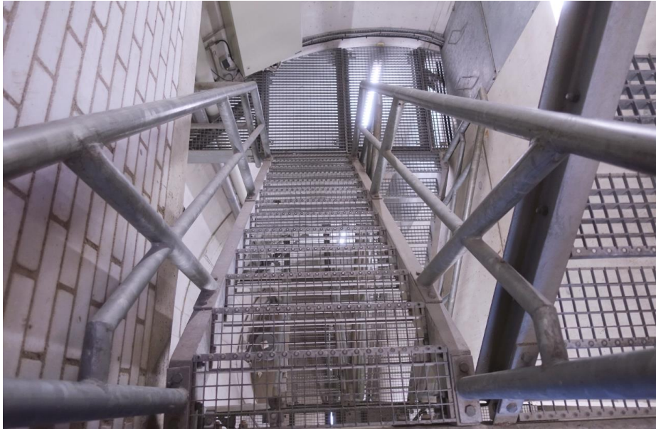
In de koker van het bedieningshuis is een trappenhuis gemaakt van bordestrappen van gegalvaniseerd staal.
