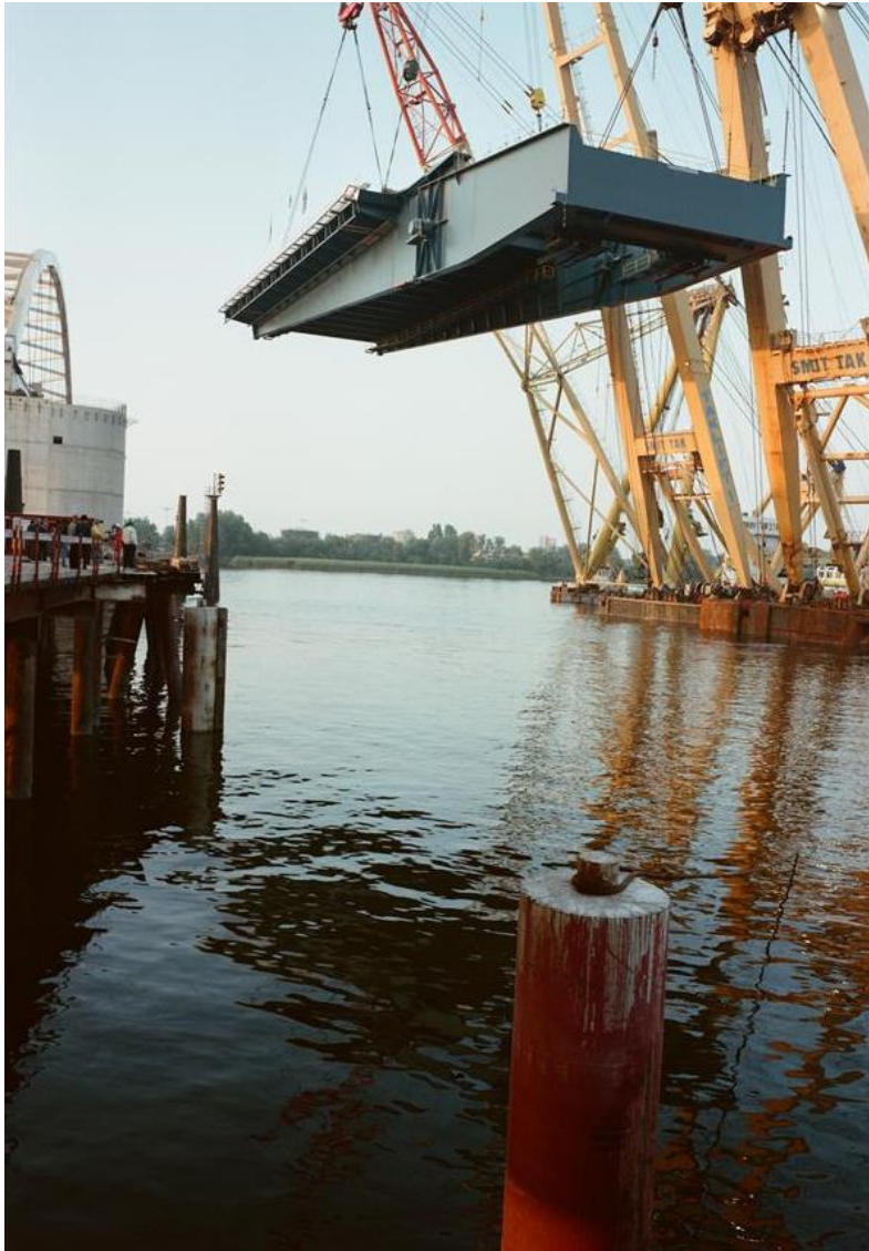
De klep van het basculedeel wordt ingehesen. RWS beeldbank, nr. 982-071, fotograaf: Bart van Eyck.
