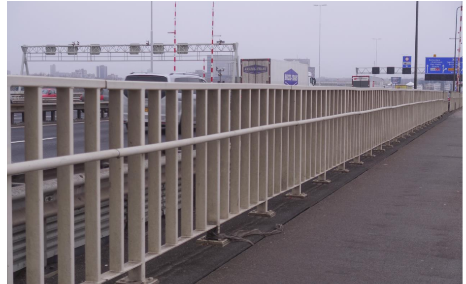
De leuning uit 1965 tussen fietspad en snelweg gezien richting het noorden.
