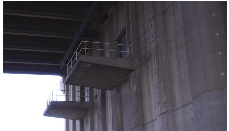
Detail van de betonnen balkons boven de entrees in de noordgevel van de basculepijler uit 1965.
