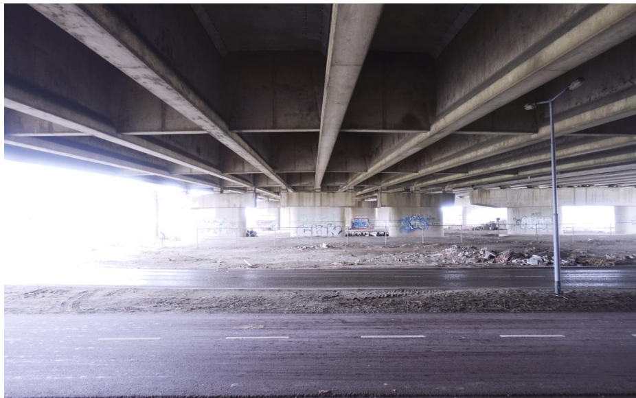
Zicht op het Toepad, een onderdoorgang bij de aansluiting van de noordelijke aanbrug op het landhoofd.
