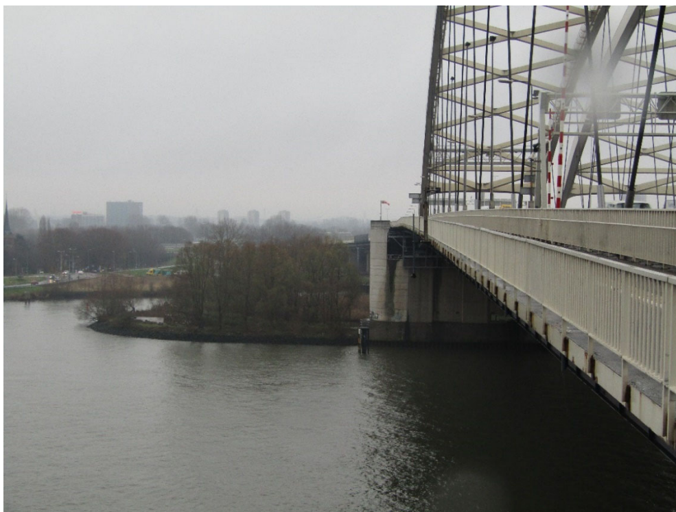
Figuur 3: uitzicht vanaf een van de pijlers van de brug richting het zuiden. Het Eiland Van Brienenoord is zichtbaar, waar tevens een van de pijlers op rust.
