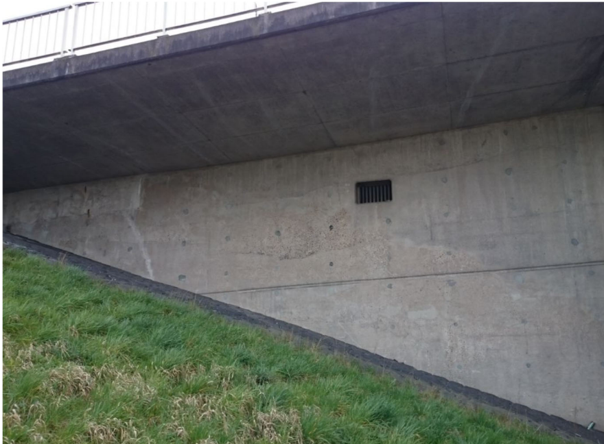
Figuur 12: een van de roosters van de Van Brienenoordbrug, welke toegang kunnen bieden aan potentiële verblijfplaatsen van vleermuizen.
