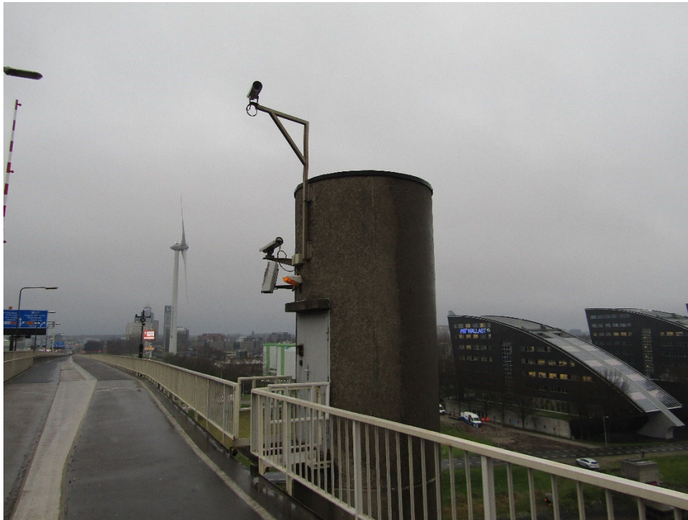
Figuur 4: Een liftkoker aan de noordoostzijde van de brug. Deze is opgetrokken uit massieve betonnen delen, waarbij de naden nog altijd zorgvuldig zijn dichtgekit.
