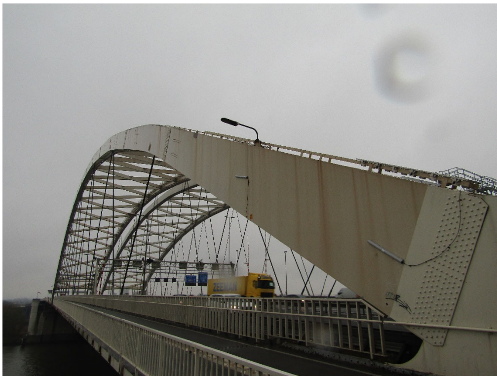
Figuur 2: de oostboog van de Van Brienenoordbrug.
