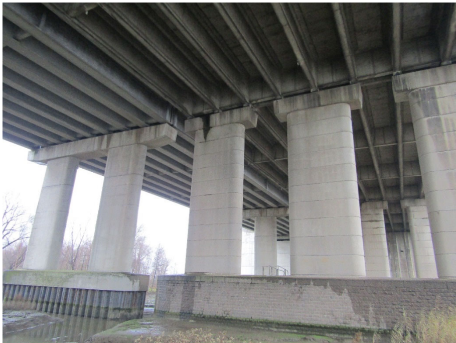
Figuur 8: de pijlers op het vasteland bestaan uit massieve betonelementen.
