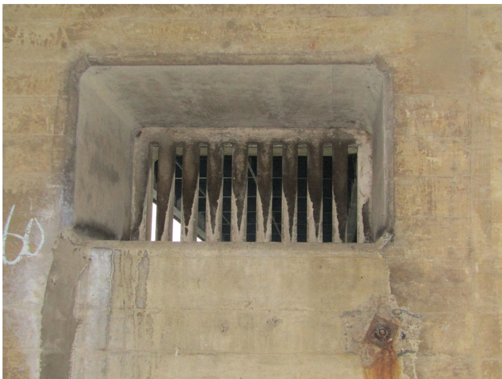
Figuur 7: een aantal pijlers zijn hol en derhalve geventileerd met behulp van grote roosters en kieren.
