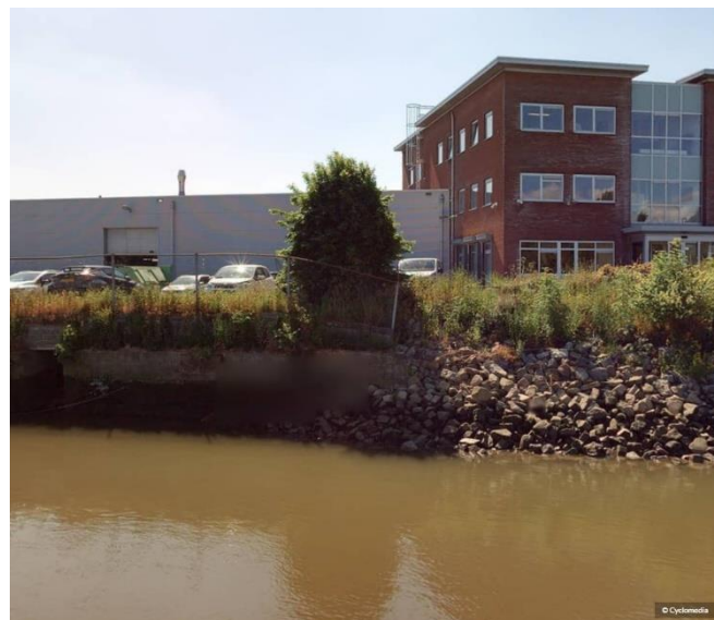
Bekleding Eiland van Brienenoord (links) en zuidoever (met overgang kade naar talud)
