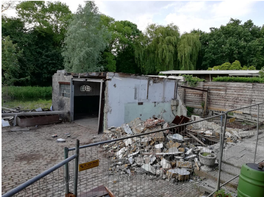
Figuur 1 Schuur A is deels gesloopt.
