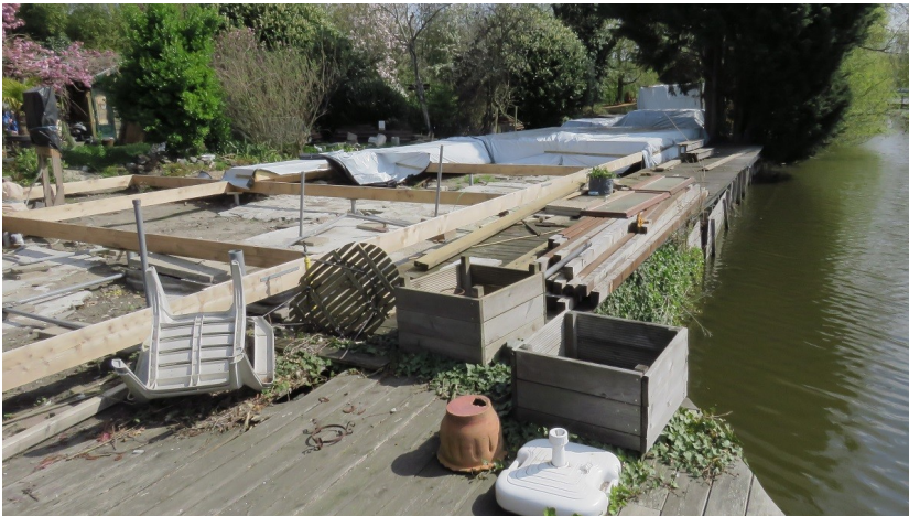
Afbeelding 3: Zicht op de bouwlocatie, kijkrichting oost
