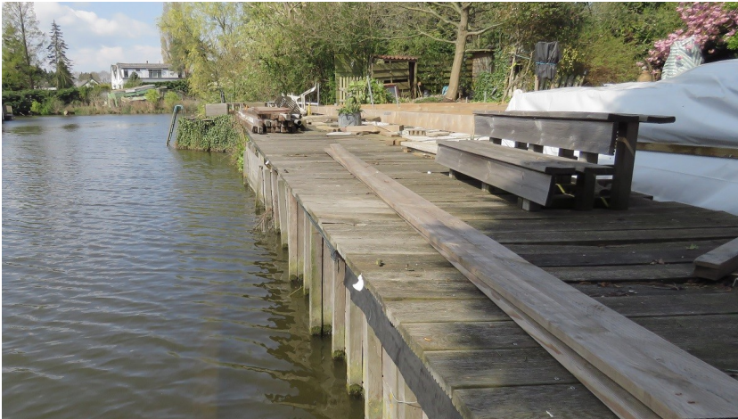
Afbeelding 8: De houten beschoeiing blijft intact, enkel de vlonderplanken zullen worden vervangen.
