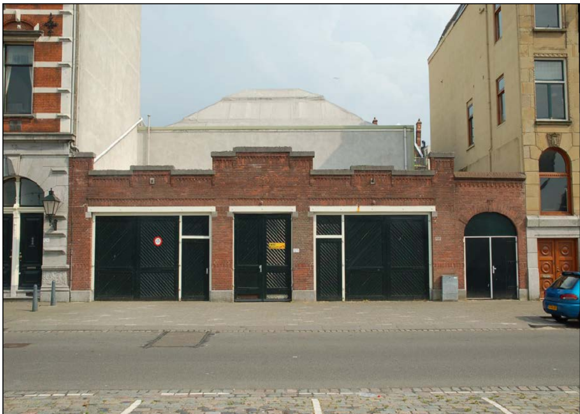
Afbeelding 4: Zicht op bestaande bebouwing aan de Maaskade.
