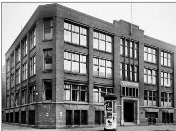
Figuur 2.1 Aangezicht van de oorspronkelijke zuidgevel
