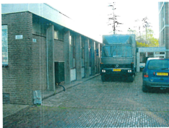
Foto 3: situering voormalige 6.000 liter HBO-tank met links het kerkgebouw en rechts het bejaardenhuis
