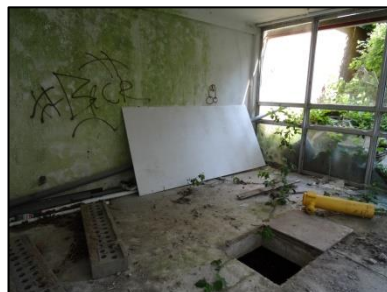
Figuur 7. Binnen het grootste gebouw, met toegankelijke ramen en kruipkelder. De onderzoekslocatie is grotendeels verwilderd, wat rechts op de achtergrond enigszins te zien is.
