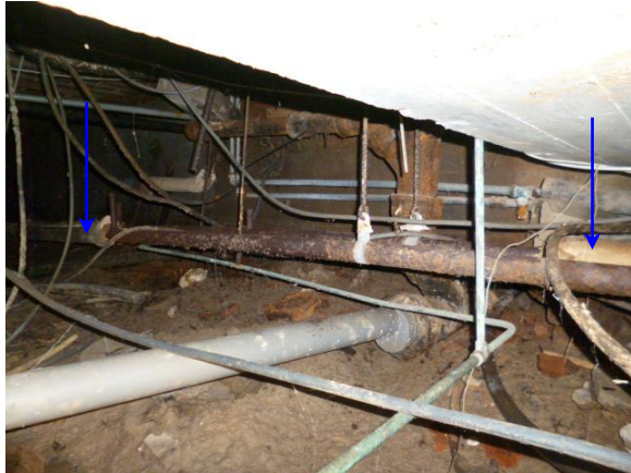
foto 1: kruipruimte leidingisolatie M10-asbestvrij
