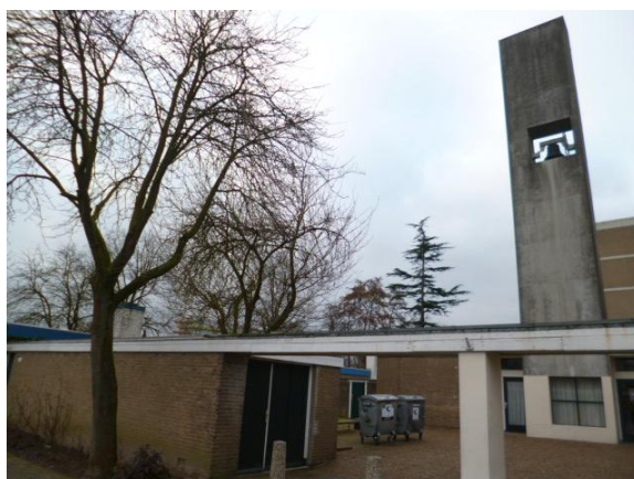
foto 12: overzicht binnenterrein Niet asbestverdacht
