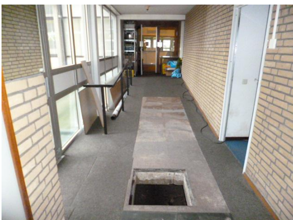
foto 11: gang tussen kerk en flat Niet asbestverdacht
