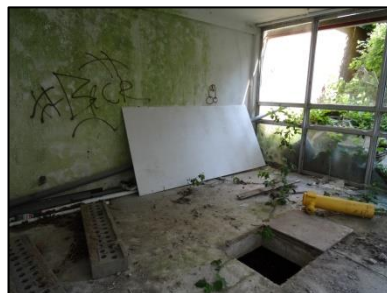
Figuur 2: Binnen het grootste gebouw, met toegankelijke ramen en kruipkelder. De onderzoekslocatie is grotendeels verwilderd, wat rechts op de achtergrond enigszins te zien is.
