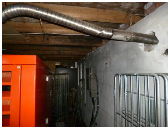
foto 10: buitenberging Niet asbestverdacht
