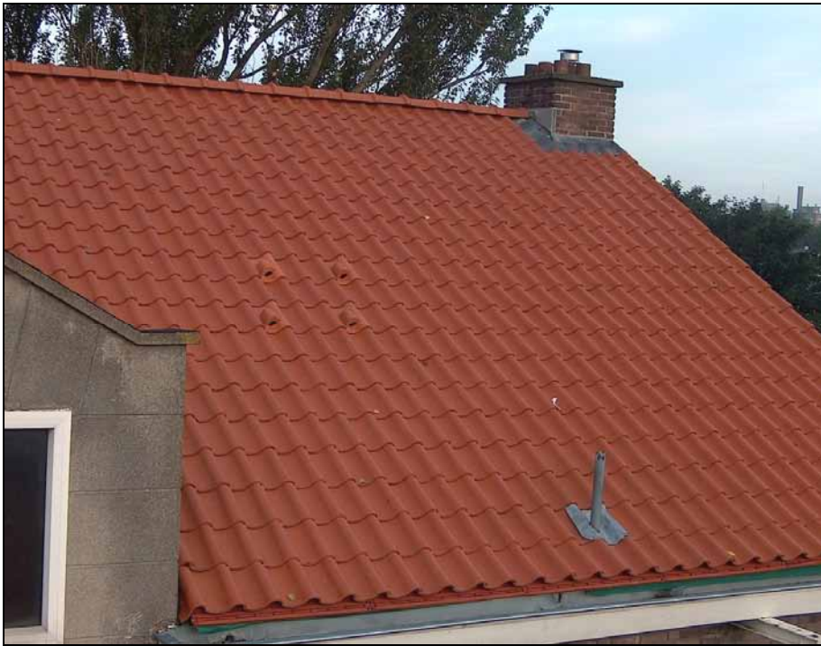
Figuur 6. Gierzwaluwdakpannen op een gerenoveerd dak in Rotterdam Crooswijk (Y. Folmer).
