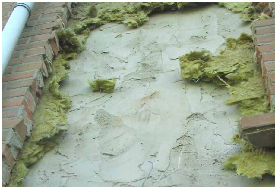
Figuur 8. Opening in de buitenzijde van een spouwmuur. Door het aanbrengen van meerdere openingen ontstaat een tochtstroom waardoor vleermuizen niet zullen terugkeren (F. Brekelmans).
