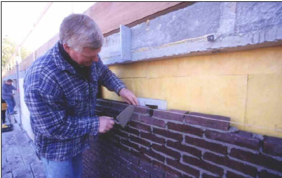
Figuur 7. Het in metselen van een betonnen gierzwaluwnestkast (Gierzwaluwbescherming).
