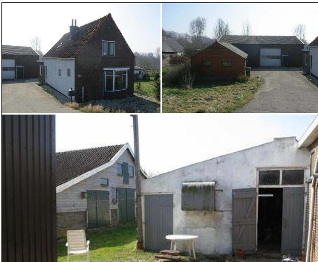
Afbeelding 6: Overzicht van de huidige bebouwing in het projectgebied.
