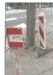
Binnen de stabiliteitskruit van de plataan hebben graafwerkzaamheden plaatsgevonden.
