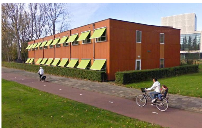
Figuur 5. Voorgevel Oost
