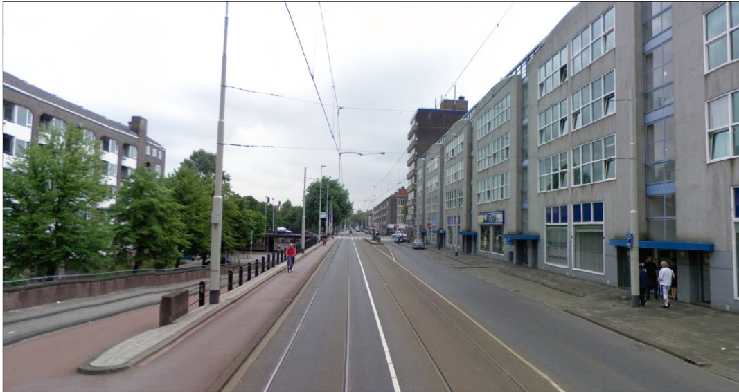
Figuur 3.3 Aanzicht Oostzeedijk (bron: Google Maps)
