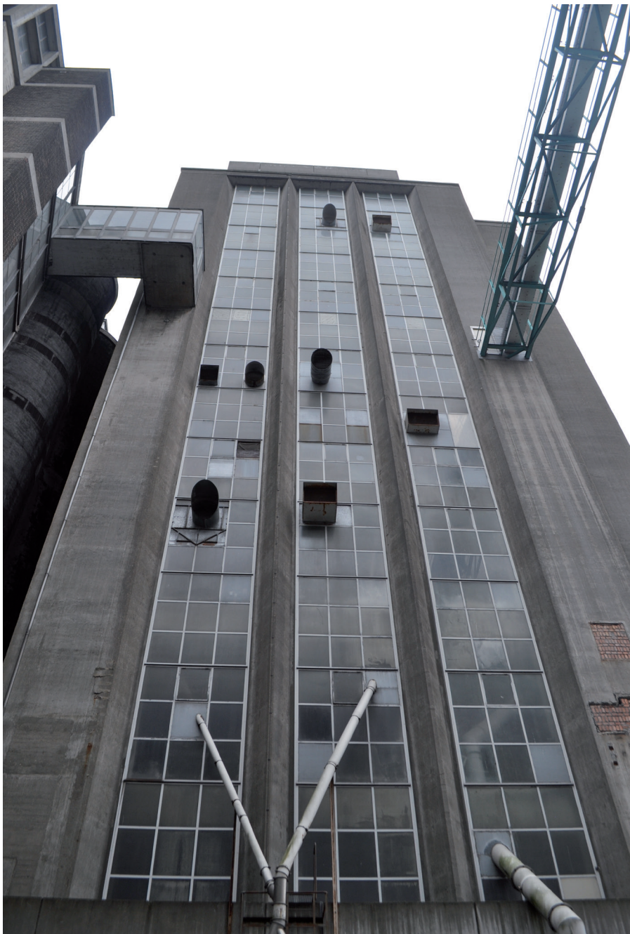
Raampartij van de noordgevel van de elevatorstoren
