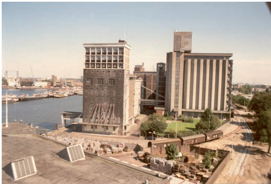
Foto na de aanpassing van de puien in de westgevel van de 9de en 10de verdieping van het zakkenmagazijn (Collectie Codrico Rotterdam BV)
