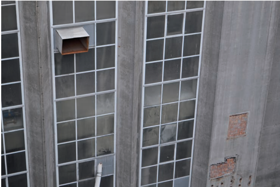
Dichtgemetseld gat waar voorheen de transportband doorheen liep
