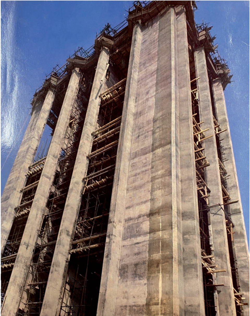
De eerste fase van de bouw, met de betonnen elevatorstoren, 1964 (Archief Vegter, HNI)
