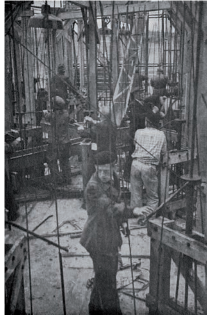
De vitzelinrichting voor de glijbekisting (Bouwkundig Weekblad)
