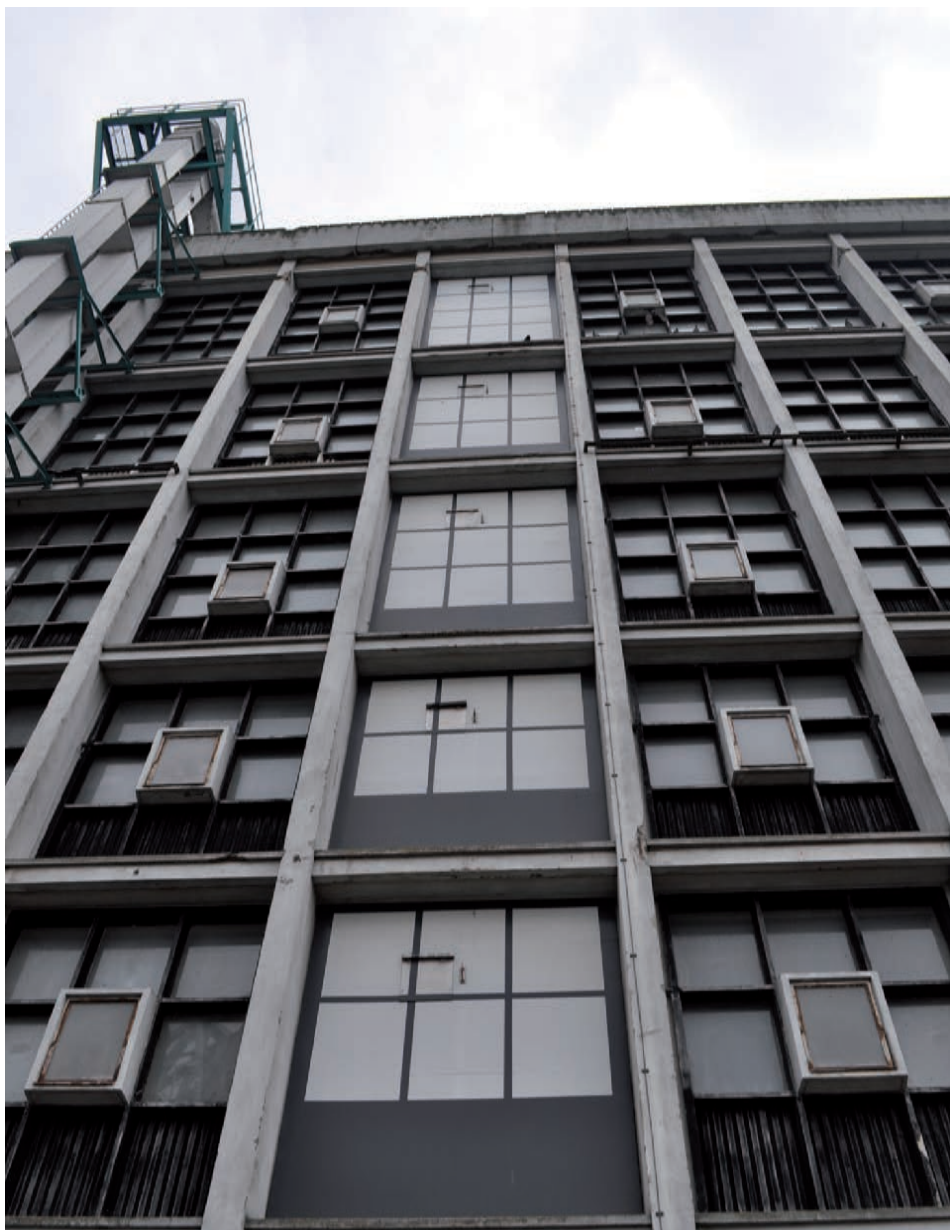
Herstelde travée aan de noordzijde van het hoofdgebouw met geschilderde kozijnindeling, waardoor de installaties naar binnen zijn gegaan
