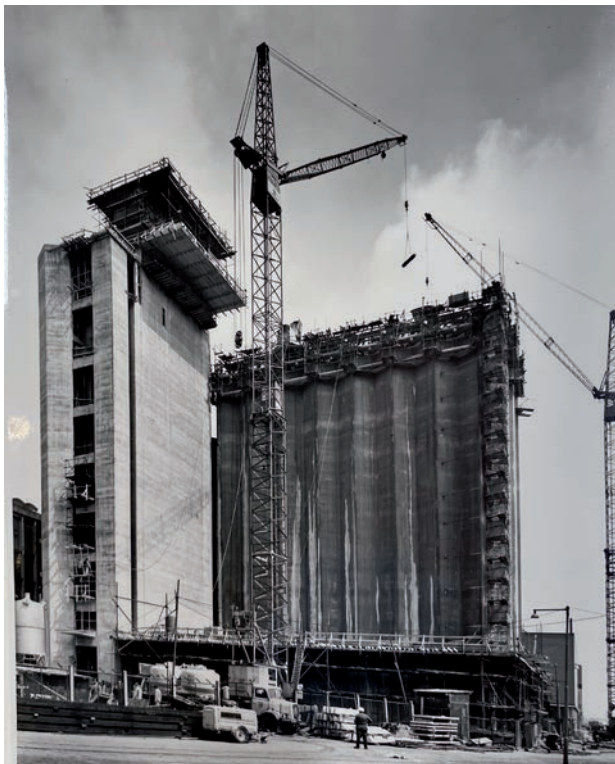
De tweede fase van de bouw, storten van de silowanden, 1964-1966 (Archief Vegter, HNI)
