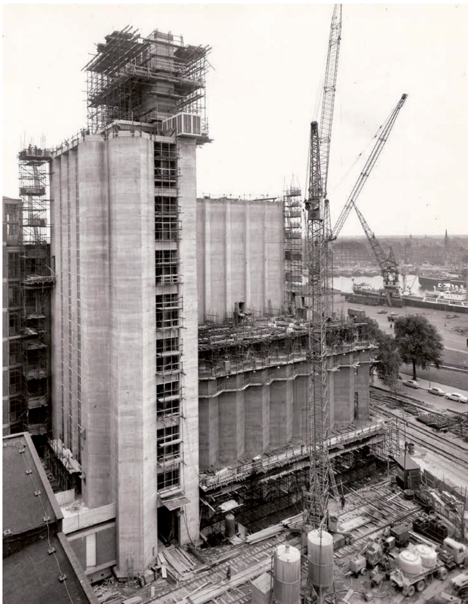
De tweede fase van de bouw, storten van de silowanden, 1964-1966 (Archief Vegter, HNI)
