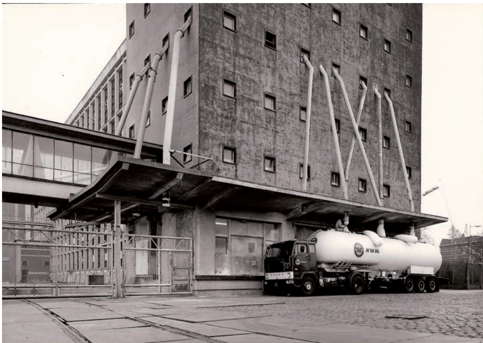
Luifels met stortbuizen aan het zakkenmagazijn (Collectie Codrico Rotterdam BV)
