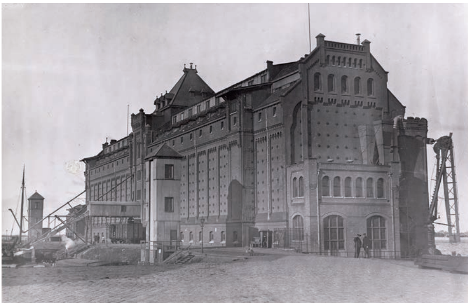
Silo's van Korthals Altes (1898) aan de Silodam in Amsterdam (Collectie Stadsarchief Amsterdam)
