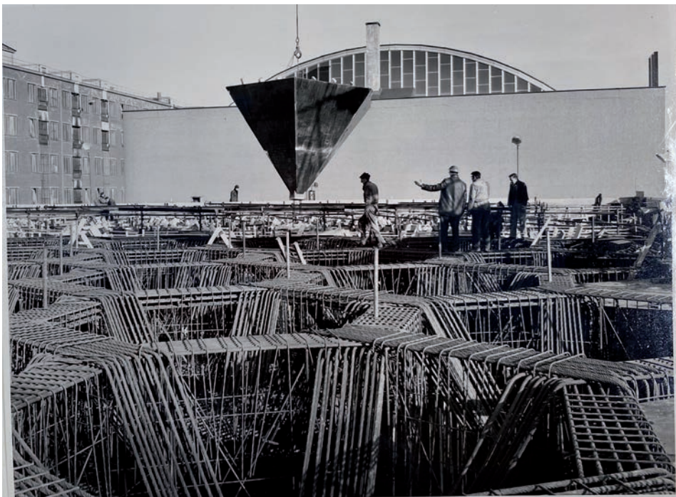
De tweede fase van de bouw, wapening van de trechtervormige silomonden, 1964-1966 (Archief Vegter, HNI)
