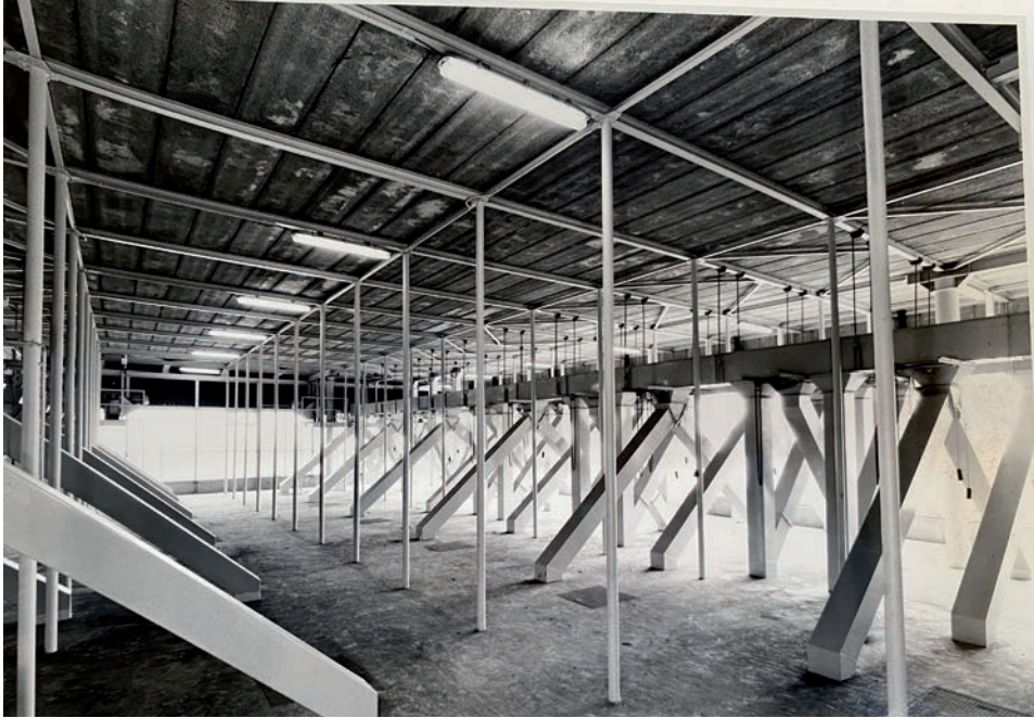
Het cellendek boven de silo's, met transportleidingen om graan in de cellen te storten (Archief Vegter, HNI)
