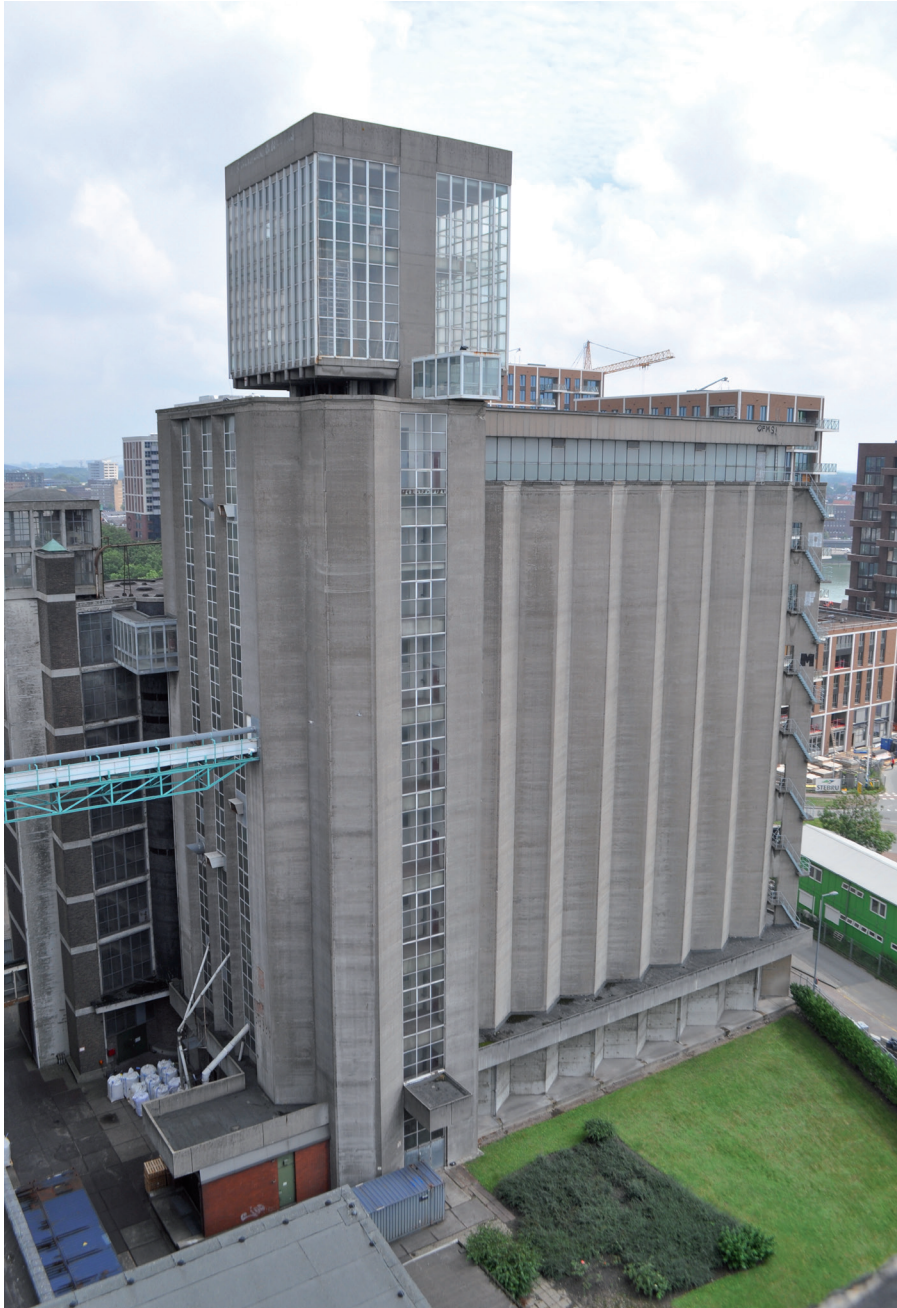
Aanzicht van de hoek van de noord- en westgevel
