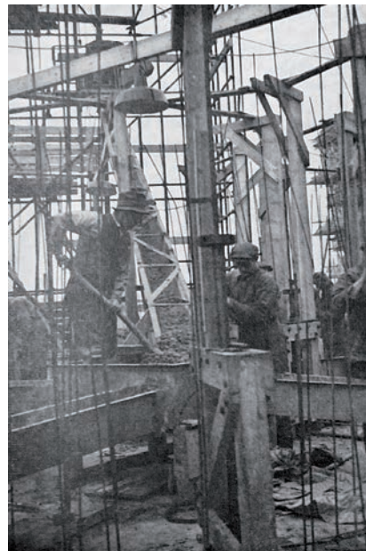
De stortgaten voor de glijbekisting (Bouwkundig Weekblad)
