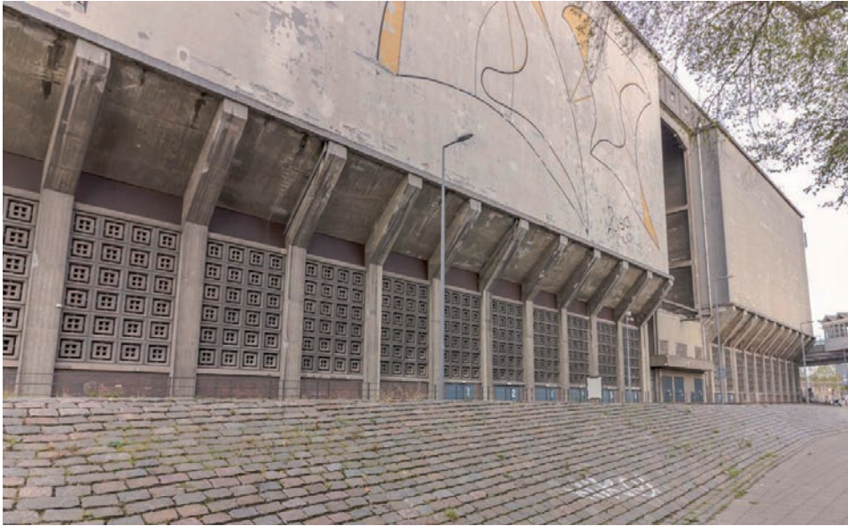
Uitbreiding van de graansilo aan de Maashaven (1951) van A.G. Postma en J.D. Postma (Ondermaas)
