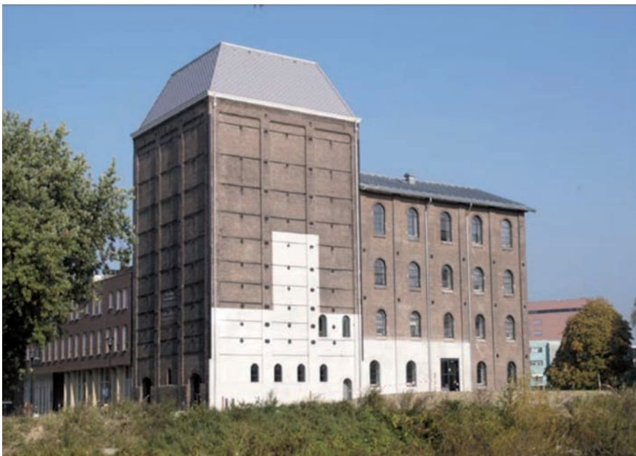
Silo en pakhuis van firma Weijers (1891) in Deventer (Architectenbureau L. Lafour en R. de Wijk)
