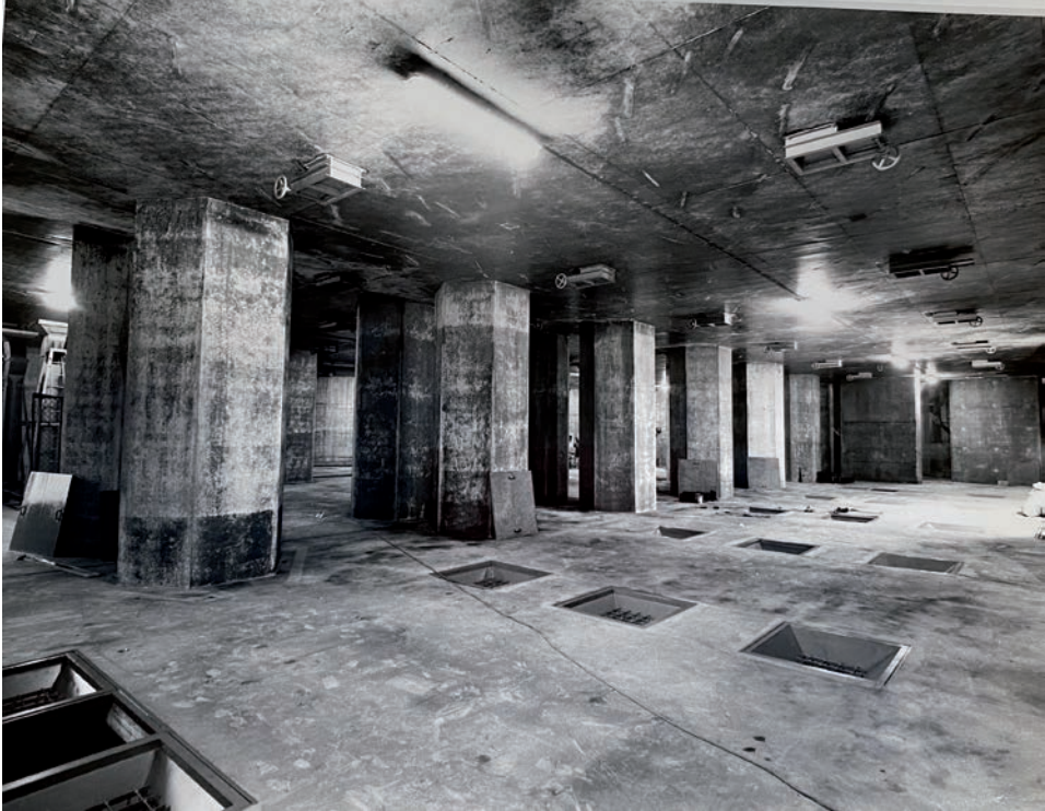
Begane grond van de silo-uitbreiding, met zware constructie en roosters in de vloer naar de kelder (Archief Vegter, HNI)
