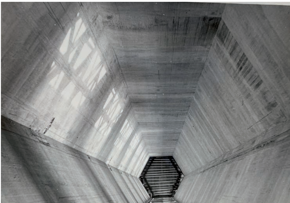
Een zeshoekige cel van de silo-uitbreiding (Archief Vegter, HNI)
