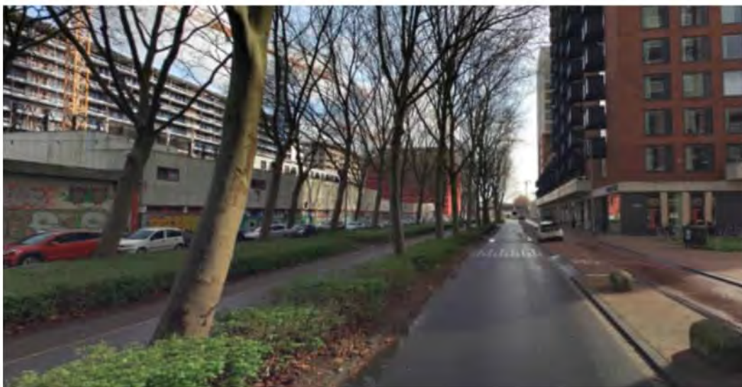
F 6 Huidige situatie Brede Hilledijk
