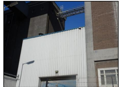
Figuur 12. Zicht op het fabriekscomplex met aan de linkerkzijde de oudere productiehal en aan de rechterzijde de silo's (kijkrichting naar het westen).
