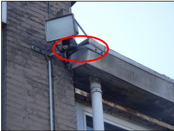
Figuur 20. Detailfoto van aansluiting tussen het kantoorgebouw en de gelijkvloerse hal. Zichtbaar is ruimte tussen de buitenmuren en een opstaande daklijst.
