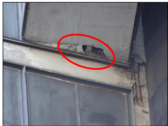
Figuur 19. Detailfoto van luchtbrug tussen silo en productiehallen. Aangegeven met de rode cirkel is een gat in de betimmering waar nestmateriaal uitsteekt.
