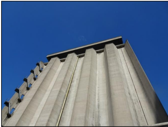
Figuur 26. Zicht op de onderzijde van de silo's.
