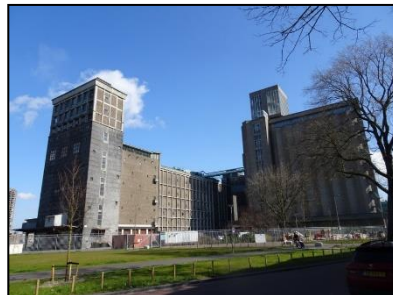
Figuur 14. Overzichtsfoto van het fabriekscomplex met aan de linkerkzijde de productiehal en aan de rechterzijde de silo's (kijkrichting naar het noordoosten).
