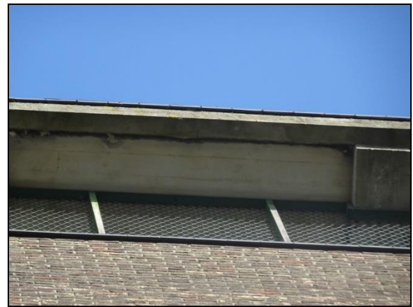
Figuur 23. Detailfoto van het rooster onder de daklijst van het oude deel van de productiehal.
