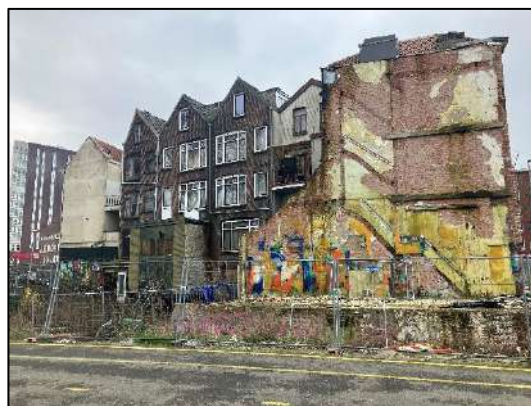
Figuur 3. Aanzicht op achterzijde woningen blok P3. Oostelijke kijkrichting.
