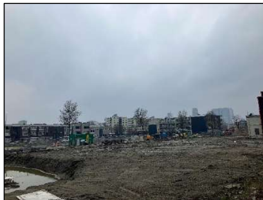
Figuur 7. Aanzicht op het bouwterrein. Westelijke kijkrichting.
