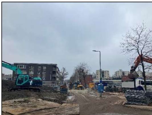
Figuur 6. Aanzicht op het bouwterrein. Westelijke kijkrichting.
