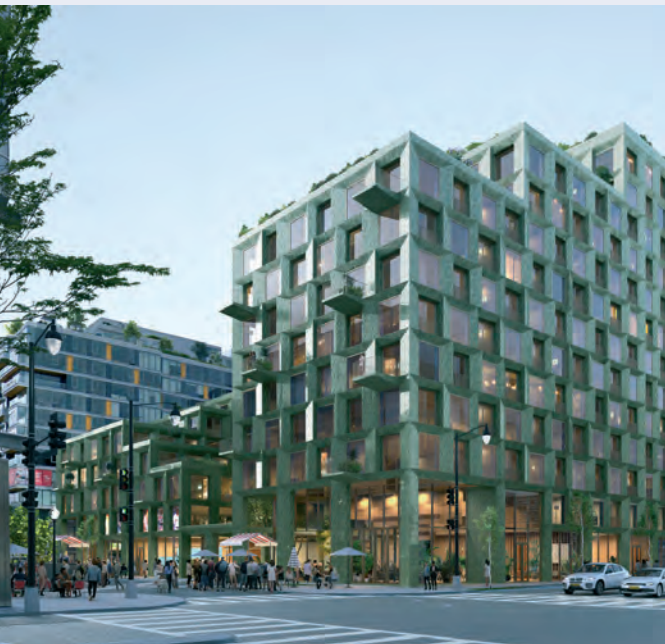
getrapte opbouw van terrassen richting het water
