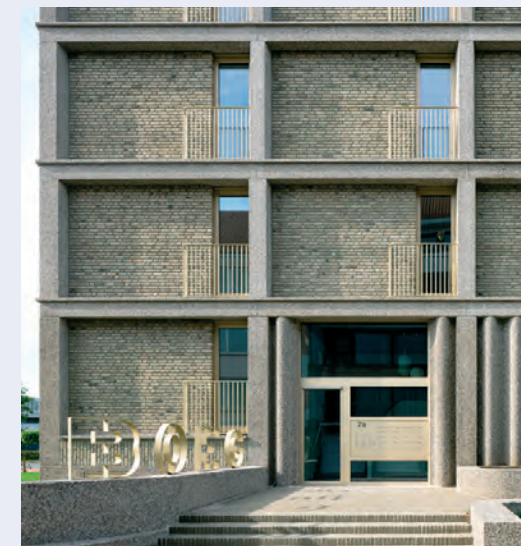
grindbeton: hergebruik van de energiecentrale
