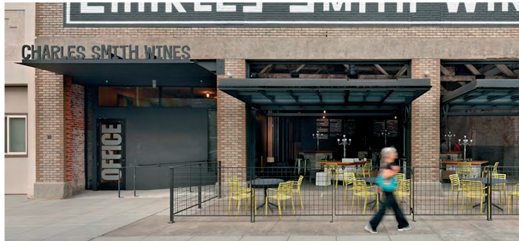
Technische ruimtes geïntegreerd in de gevels
