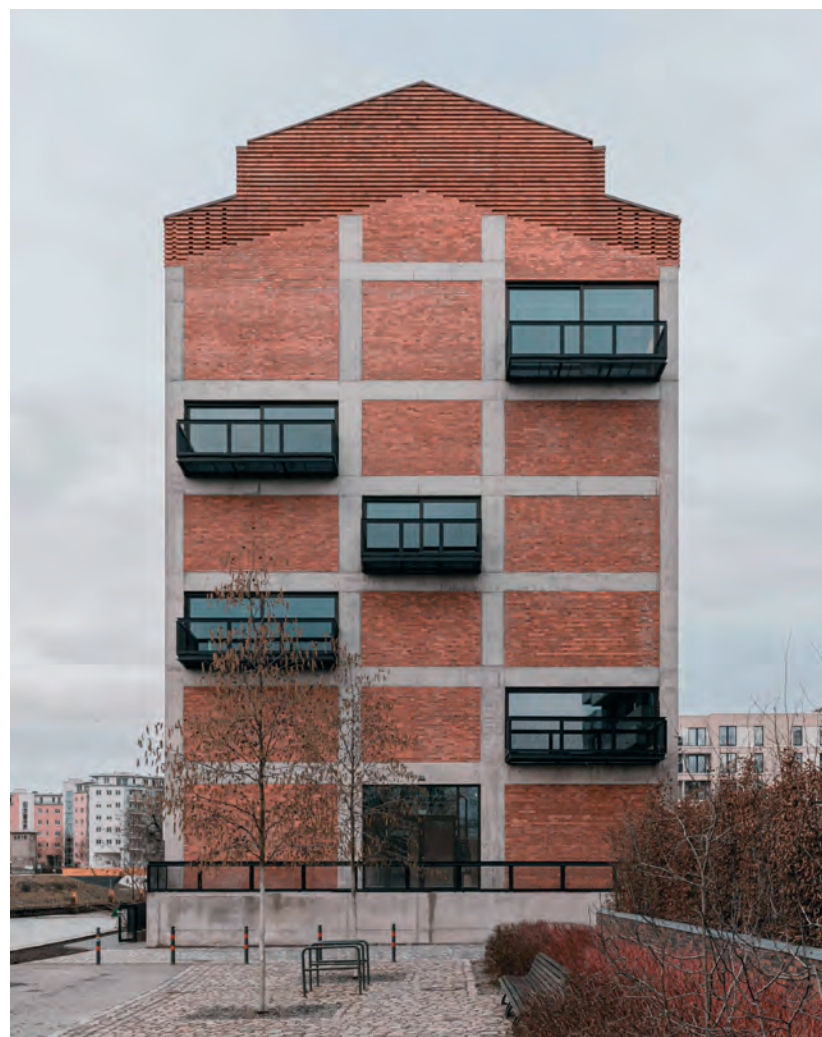
Constructie in het zicht
