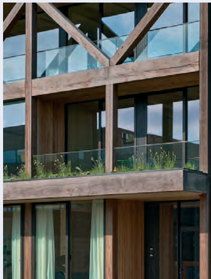
houtbouw refereert aan de werkplaats
