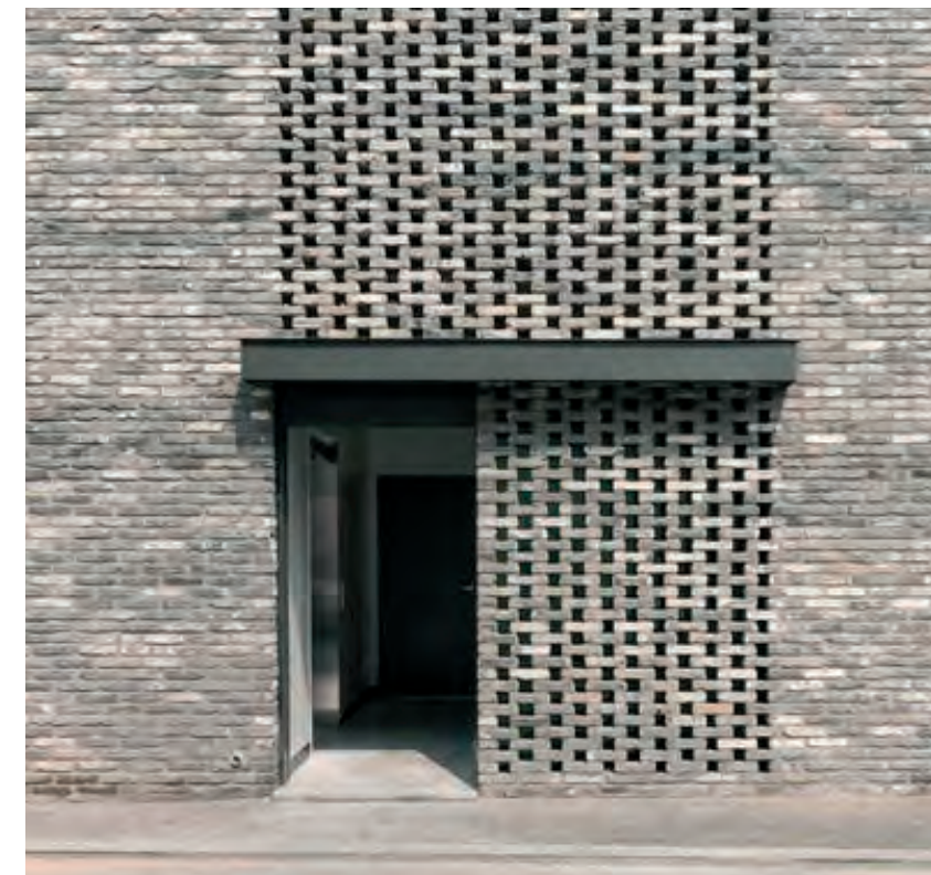
Techniek inpandig oplossen
