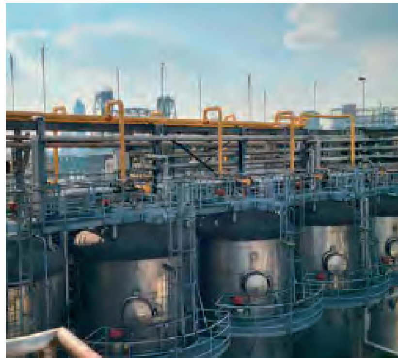
Pijpen en silo's
