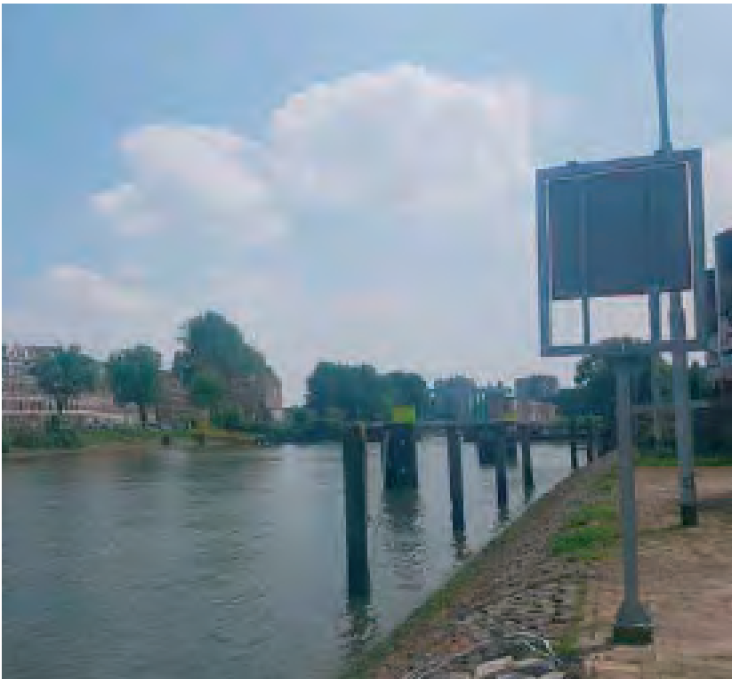
4. Kade met talud
