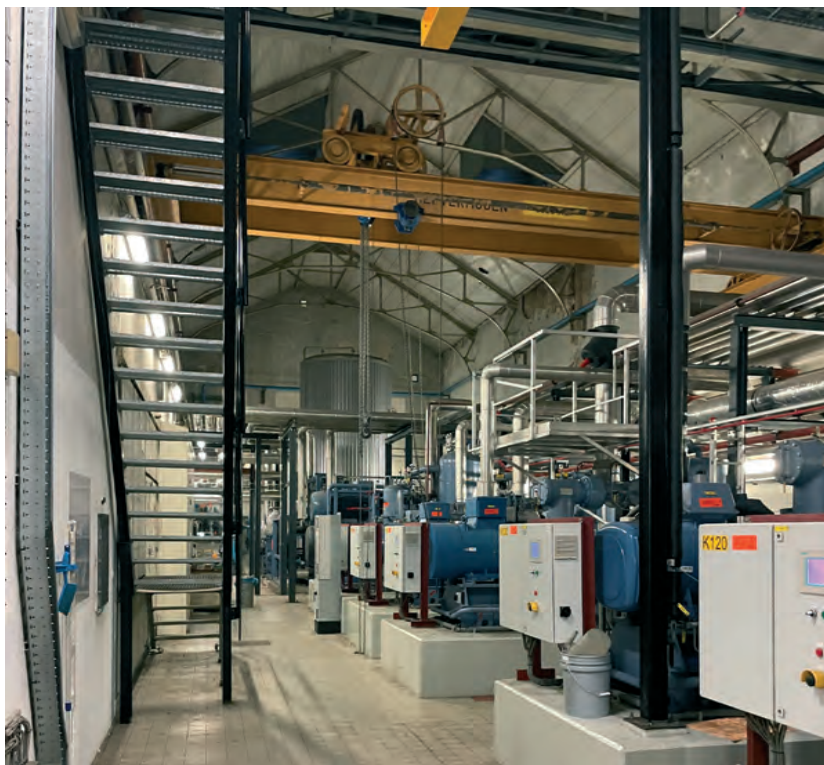
Ketelhuis en werkplaats
