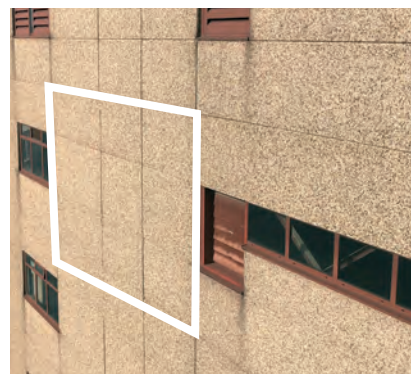
prefab betonnen platen
