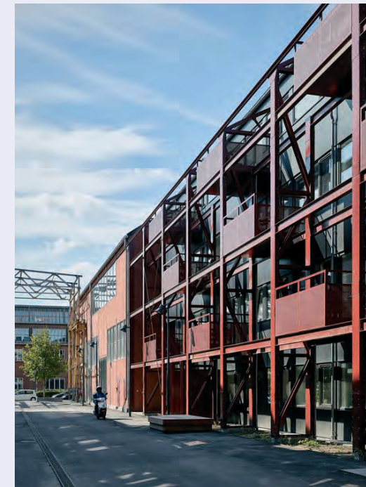
stalen trappen en corridor
