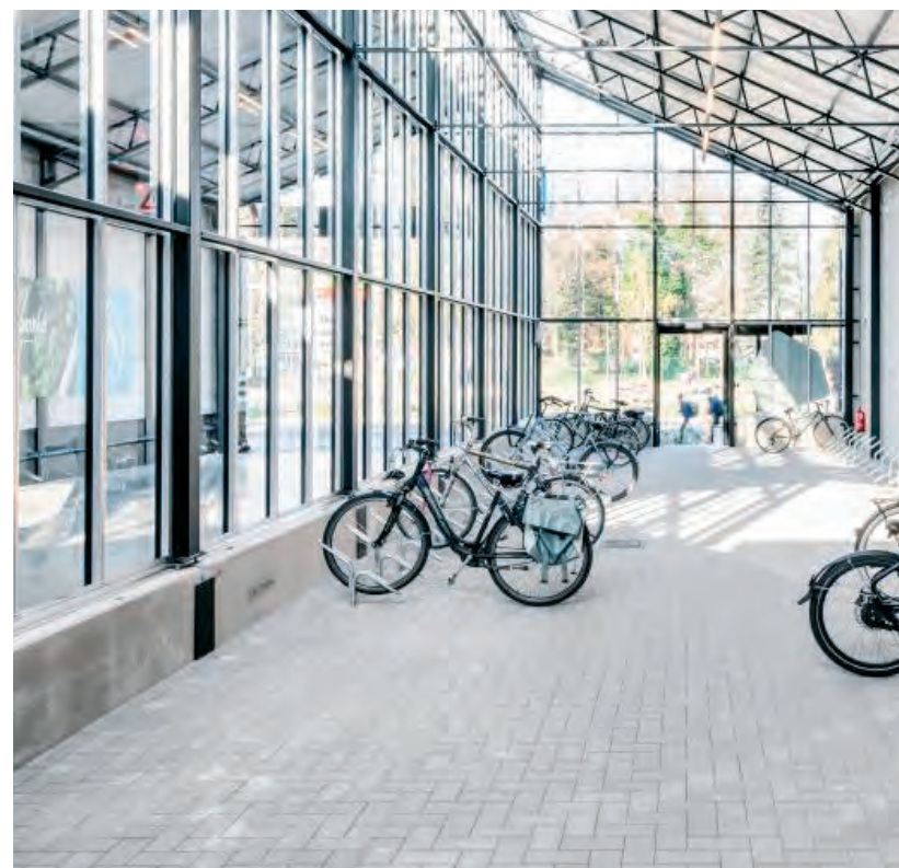
Lichte en ruimtelijke gezamenlijke fietsenstallingen
