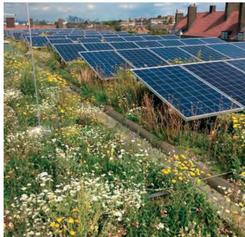
Groene daken in combinatie met PV-panelen
