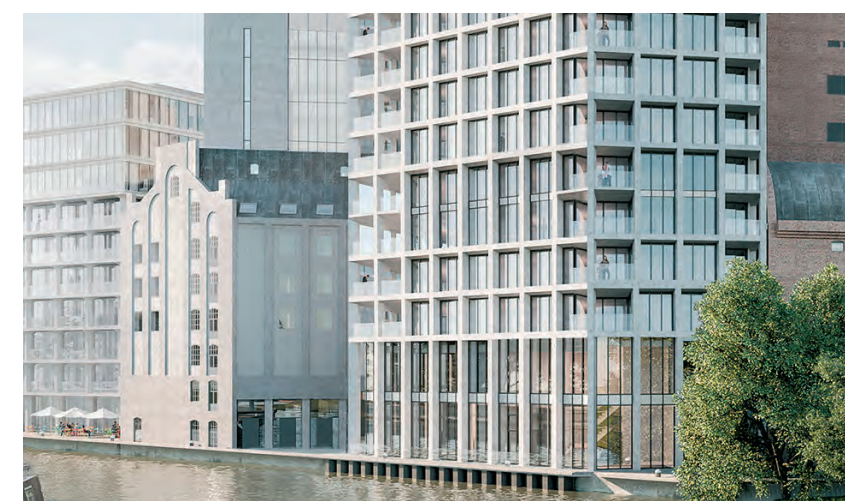
Afwisseling hoogte van de ramen, terugliggend en voorliggend
