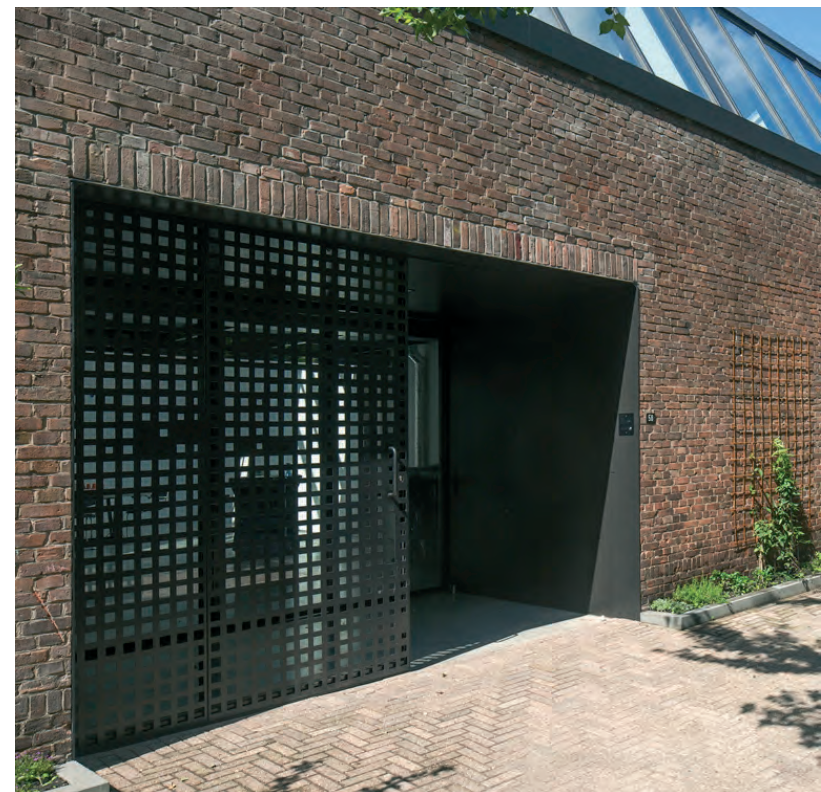
Technische ruimtes onderdeel van de architectuur
