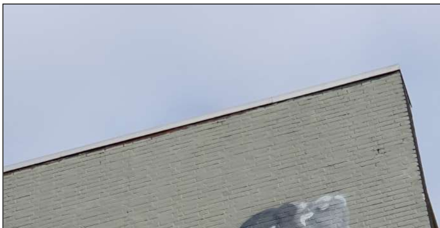
Figuur: het Heer Bokelcollege heeft een voor vleermuizen toegankelijke dakrand.
