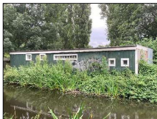
Figuur 11 Voormalig kleedkamer gebouw aan de noordkant van projectgebied. Kijkrichting zuid.
