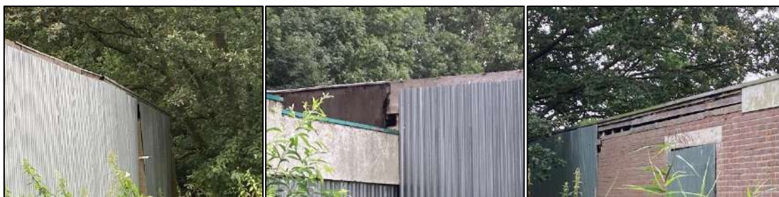
Figuur 22, 23 en 24 voormalig kleedkamer met diverse openingen
