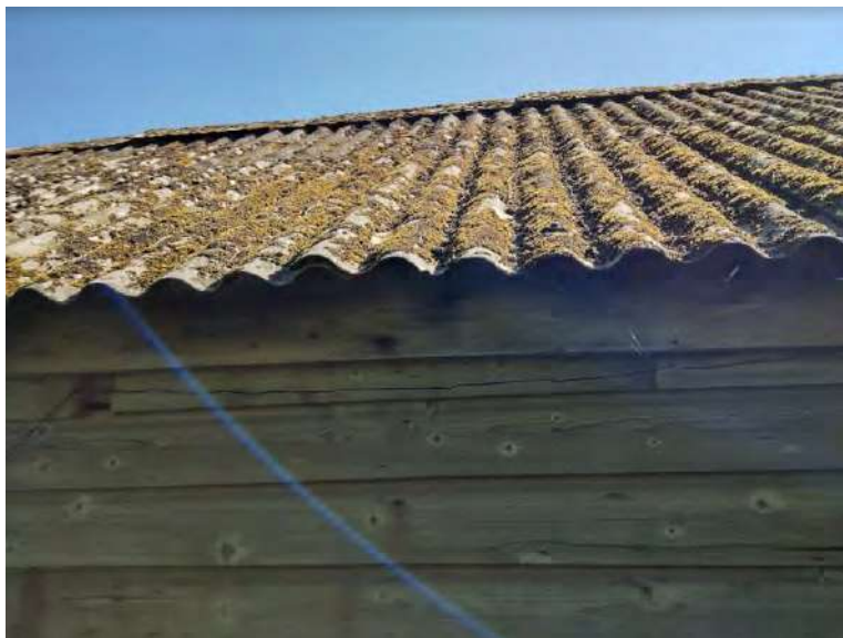
Afbeelding 3: asbestdak
