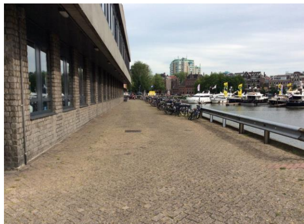
Fotonummer 12: Gericht noord ter plaatse van deellocatie 2.
