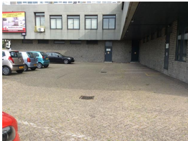
Fotonummer 14: Gericht noord ter plaatse van deellocatie 2.
