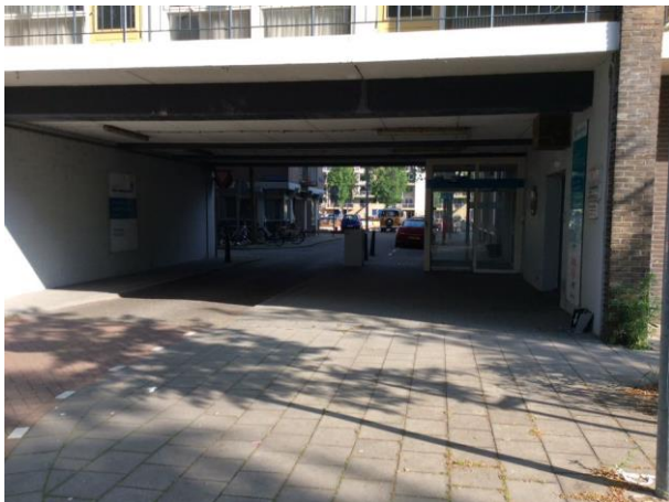
Fotonummer 3: Gericht noord ter plaatse van deellocatie 1.
