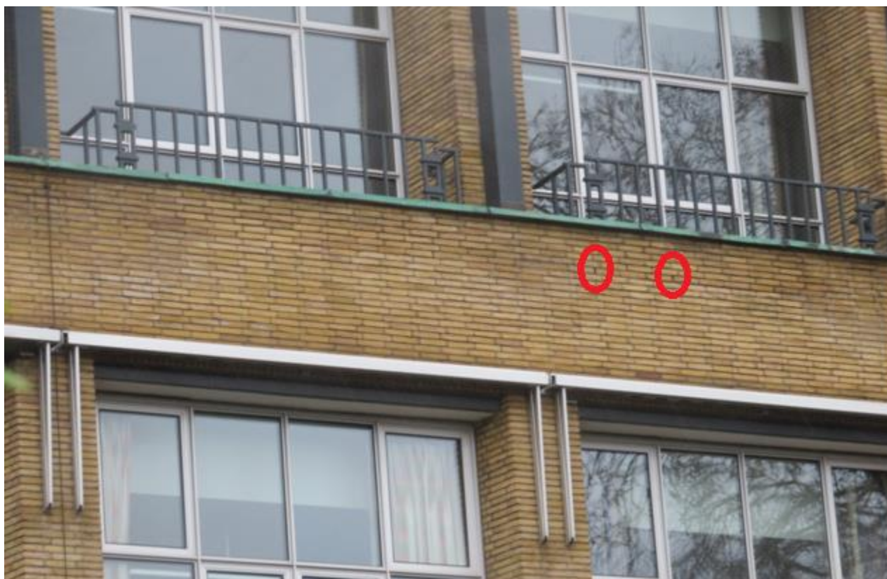
Enkele van de open stootvoegen in de voorzijde van het beeldbepalende deel. De open stootvoegen bevinden zich alleen tussen deze twee verdiepingen.
