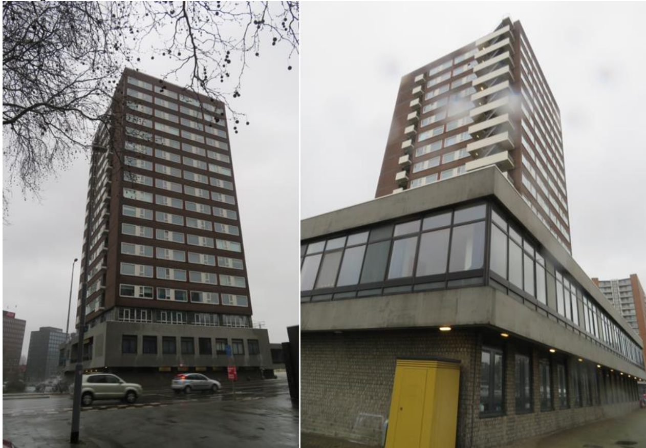
De Hoge Wiek gezien vanaf het Haringvliet en vanaf de Maasboulevard.
