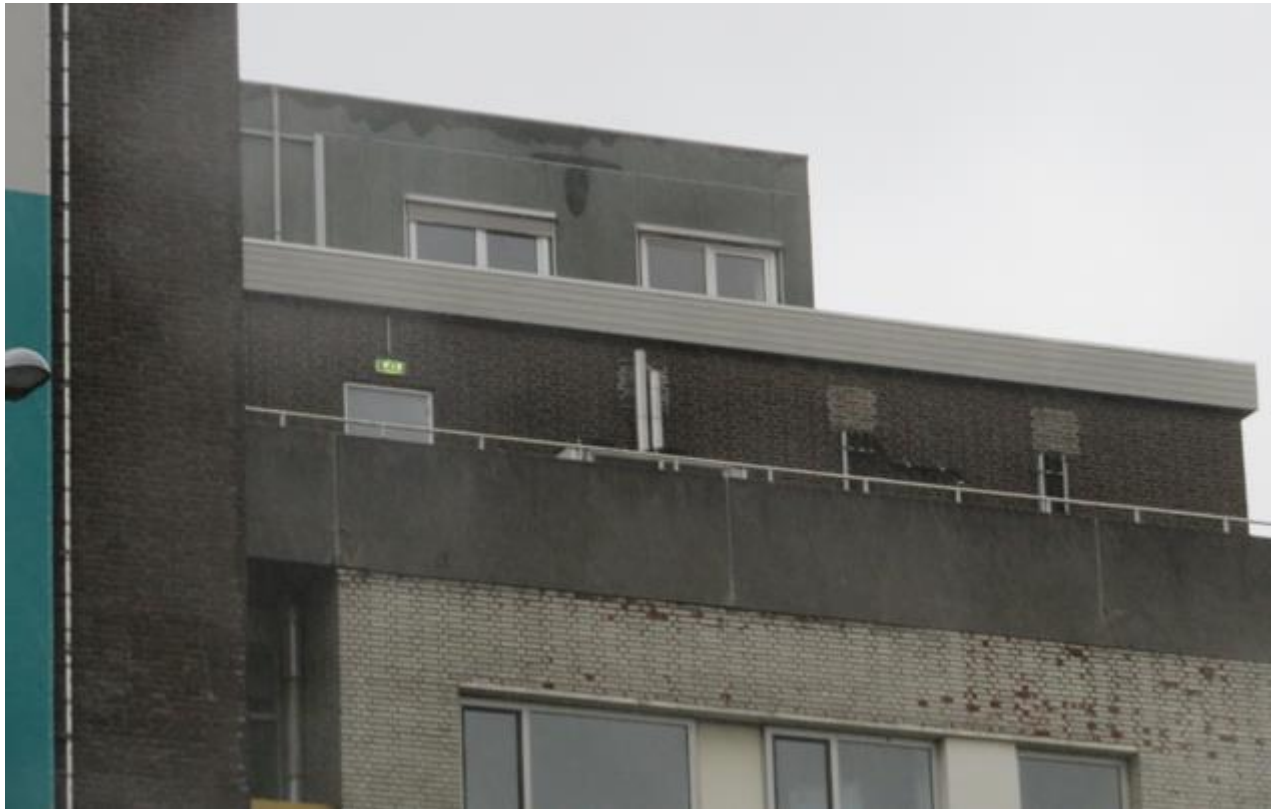
Bovenkant zijgevel oostzijde Havenziekenhuis: geen invliegopeningen aanwezig
