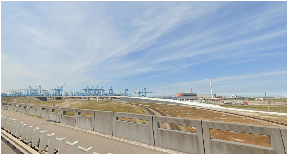
Figuur 3.1 | Boven: Zicht vanaf de Dardanellenstraat (zijstraat Europaweg) op het spoor en de locatie van het toekomstige hoogspanningsstation.
