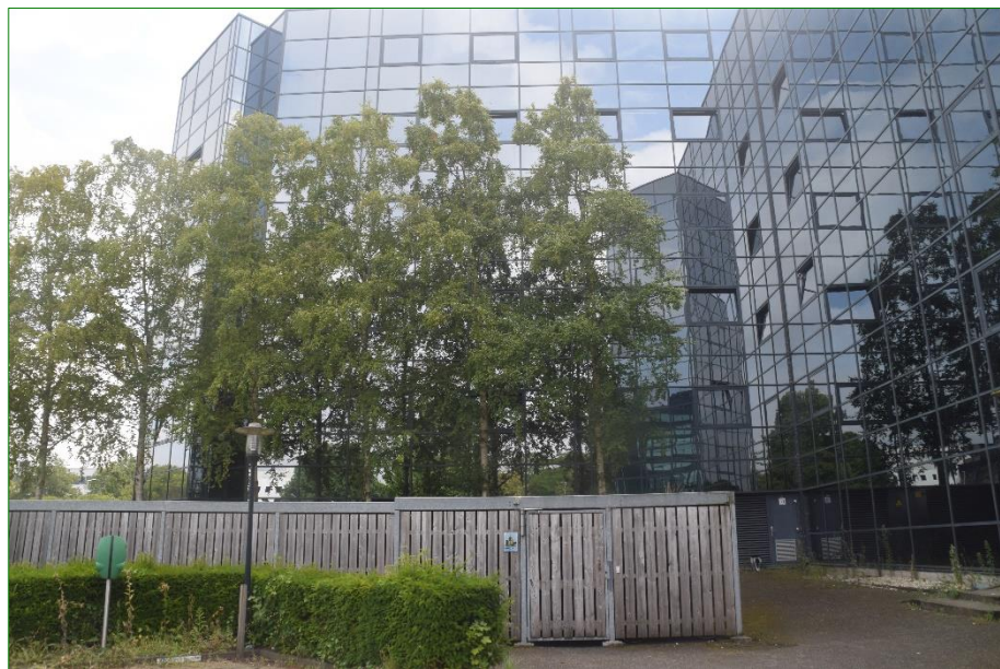
Rij berken direct naast het gebouw met hierin het eksternest.
