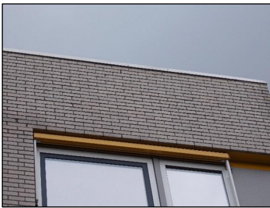
Foto 7: Metalen daklijst in gebouw D
