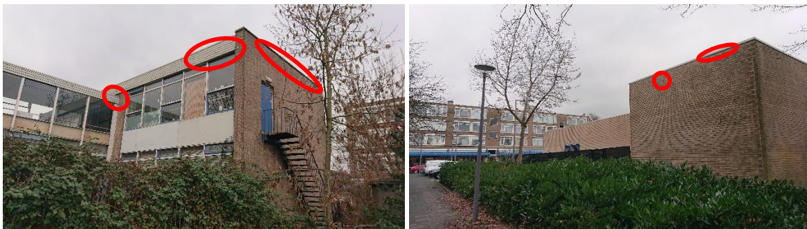
Figuur 5.1: twee foto's van de gevels van panden in het projectgebied met enkele voorbeelden van locaties waar vleermuizen kunnen weggroepen (rood omcirkeld). Dit betreffen de open stootvoegen en de ruimten achter de dakrand, betimmering en hemelwaterafvoer.
