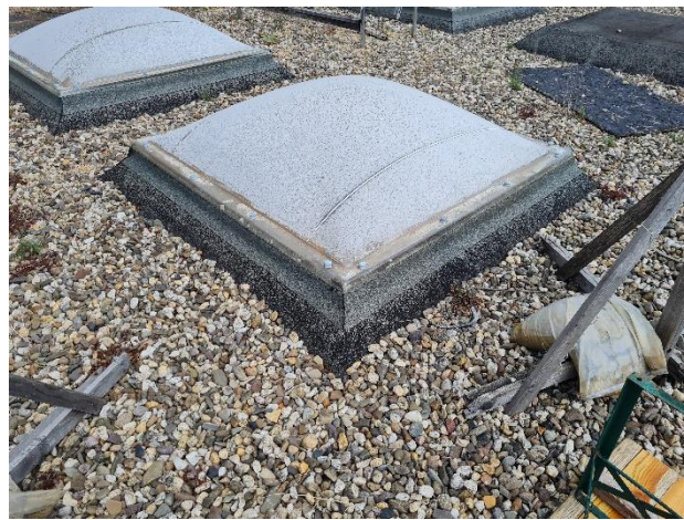
Lichtkoepels zijn aangetast door weersinvloeden.
