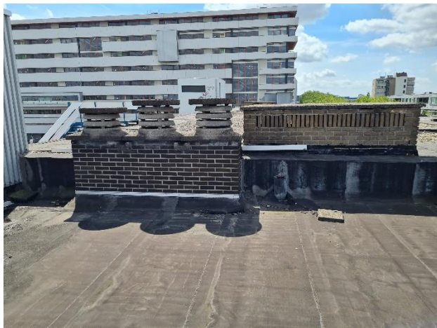
Dak aansluitingen professorisch gemaakt waardoor inwatering mogelijk blijft.
