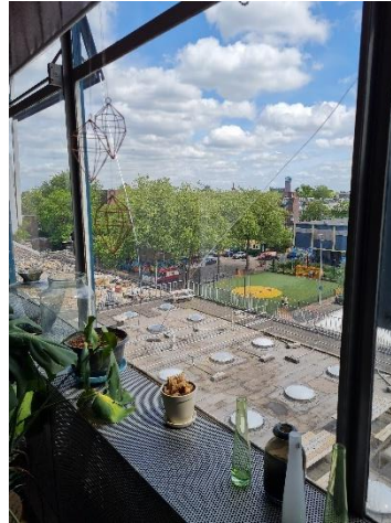
Met regelmaat breuk in enkele beglazing. Diverse oorzaken mogelijk zowel thermisch als mechanisch.
