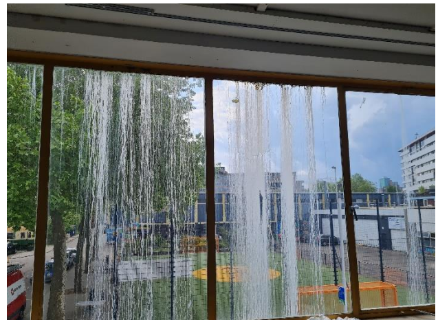
Corrosie en lekkagesporen bij stalen kozijn achtergevel.
