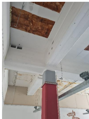
Geen noemenswaardige gebreken aangetroffen aan constructieve delen beton.
