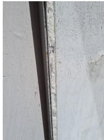
Met regelmaat aangetast stopverf dat volledig vervangen dient te worden.
