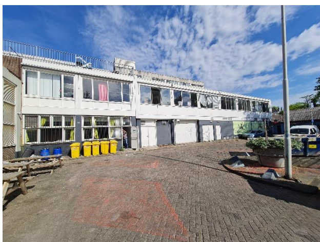
De houten kozijnen op de begane grond en eerste verdieping verkeren over het algemeen in goede staat.
