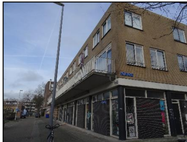
Figuur 19. Overzichtsfoto van Almondestraat 321 en Zomerhofstraat 7-11 met veel open stootvoegen.
