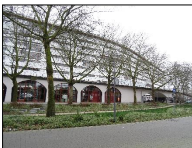
Figuur 38. Overzichtsfoto van spoorviaduct en groenstrook aan de Vijverhofstraat.
