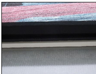
Figuur 28. Detailfoto van ruimte tussen muur en gevelbeplating van Schoterbosstraat 2-6.
