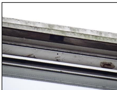
Figuur 34. Detailfoto van ruimte boven ramen tussen het hout aan de Zomerhofstraat 56-58.
