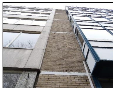
Figuur 30. Foto van Teilingerstraat 110-130 met veel open stootvoegen.
