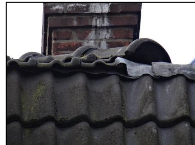
Figuur 15. Detailfoto van ruimte tussen loodslabben en dakpannen van Noordsingel 20-34.
