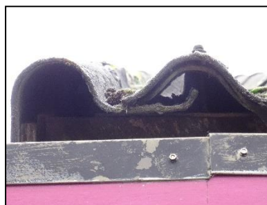
Figuur 26. Detailfoto van ruimte onder dakbeplating van Schoterbosstraat 17 (gebouw nummer 4).
