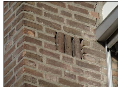
Figuur 21. Detailfoto open ventilatiespleten in muur van Almondestraat 331.
