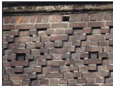
Figuur 23. Detailfoto van spleten langs bakstenen in muur van Almondepad.
