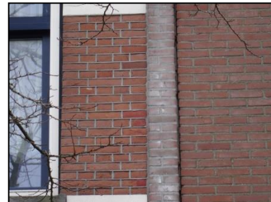
Figuur 12. Detailfoto van spleet met openingen tussen Zomerhofstraat 6-18 en 2A-2B.
