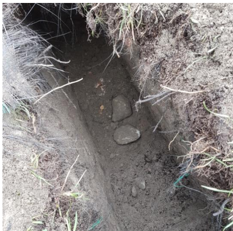
Foto 1: gegraven sleuf tpv boring 435.
