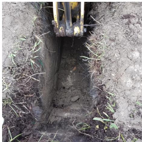
Foto 2: gegraven sleuf tpv boring 435.
