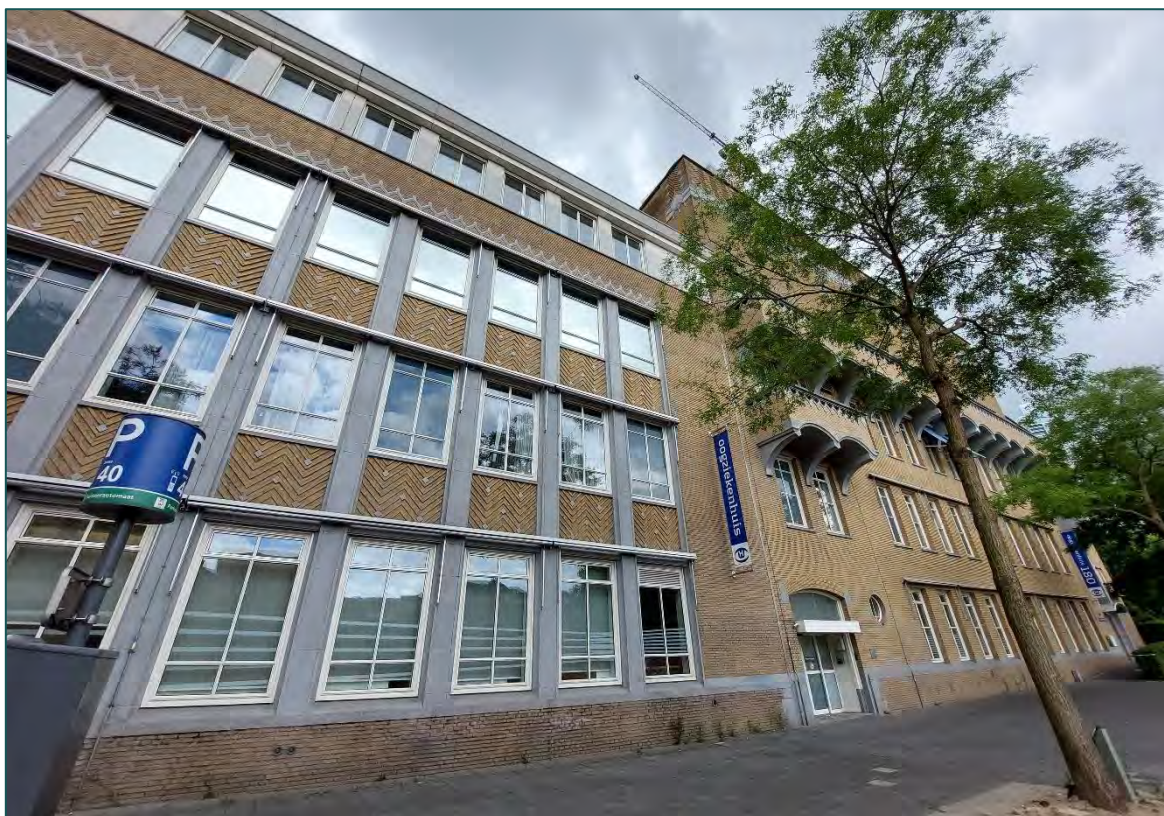
Figuur 2 De bebouwing bestaat uit gemetselde muren met spouw en platte daken. Het pand bevat een grote hoeveelheid ramen.
