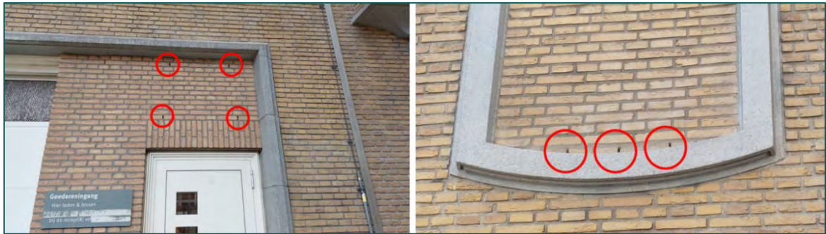
Figuur 3.1 De spouwruimte van de te renoveren bebouwing is voor vleermuizen toegankelijk via open stootvoegen in de oostelijke en noordelijke gevel.
