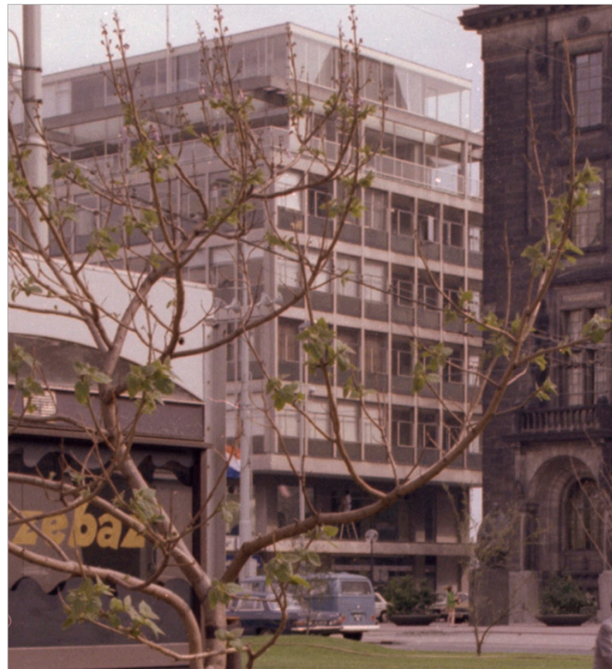
Het onderpaneel van elk raam bestond oorspronkelijk uit helder draadglas met direct daarachter een groen geschilderde lamel-radiator: een interieurelement met een hoofdrol in het gevelbeeld! Foto radiator op p. 13. Bron: Stadsarchief Rotterdam (zie de disclaimer in het colofon).
