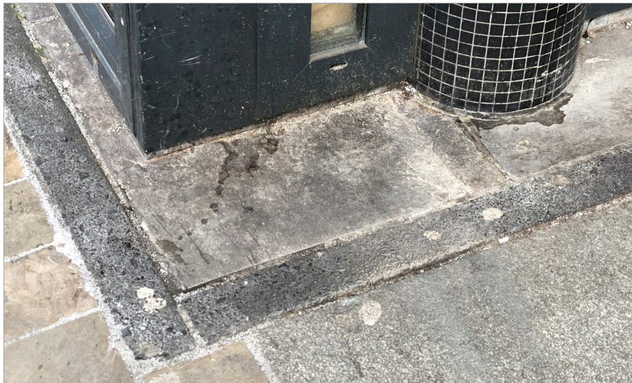
Vloerplint van groene natuursteen en zwarte bies van kunststeen aan de zijde Coolsingel. De ronde kolommen met zwarte mozaieksteentjes zijn inmiddels ingebouwd.
