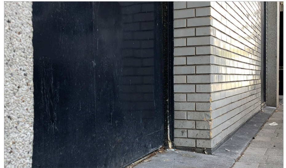
Vloerplint van zwarte kunststeen aan de Doelstraat. Karakteristiek is de combinatie mat en glans, ruw en glad, donker en licht, robuust en rank in het kleur- en materiaalgebruik.
