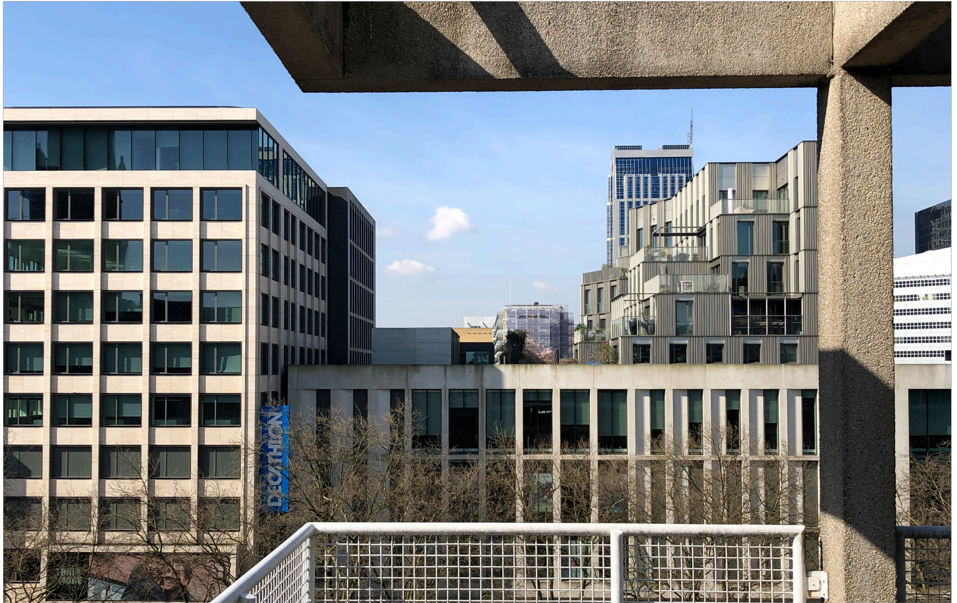
De open hoek van de pergola: relativeren van de strakke doosvorm en zuiver afleesbaar houden van de totale draagstructuur. De wit geschilderde balustrade is origineel en bestaat uit een omranding van stalen pijpen met daartussen verzinkt geweven gaas.
