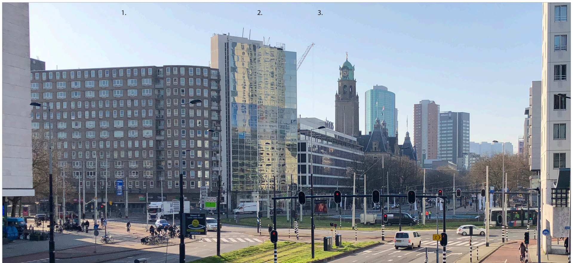
Overzicht van de hoek Pompenburg, Hofplein en Coolsingel met de drie te slopen gebouwen: 1. Pompenburgflat (1981), 2. 'Spiegeltoren' (1987) en 3. Cools / EN-NEN gebouw (1954-1959).
