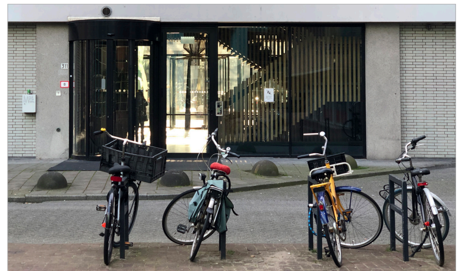
Boven: betonconstructie in het zicht. De verwarmingskoof onderlangs de ramen is nieuw (was lamel-radiatoren voor een onderpaneel van draadglas). Onder: doorzicht van Doelstraat naar Coolsingel.
