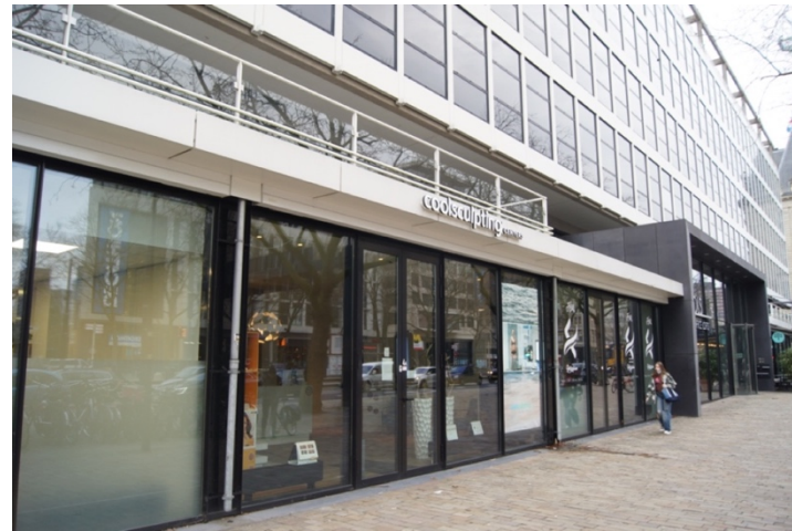
De plint heeft een glazen pui en een met aluminium bekleed betonnen overstek (2018). Daarbovenop staat een witte balustrade (1959).
