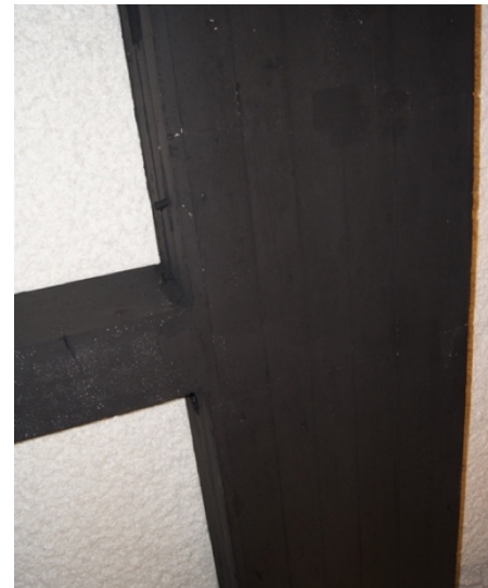
De betonnen balklagen, gegoten in een houten bekisting, zijn zichtbaar in het plafond.
