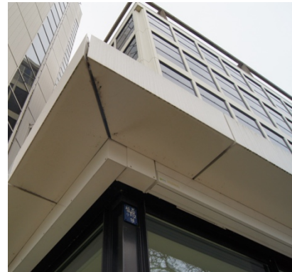
Betonnen overstek met aluminium afdekking, voorzijde plint
