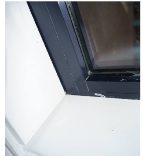
De kozijnen op de derde t/m zesde bouwlaag uit 1987 zijn van kunststof.
