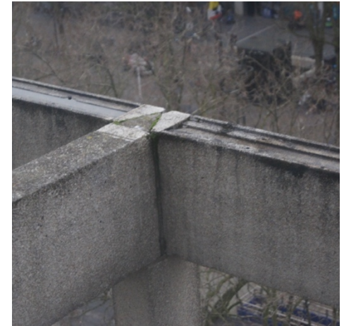
De betonnen pergola van boven gezien.
