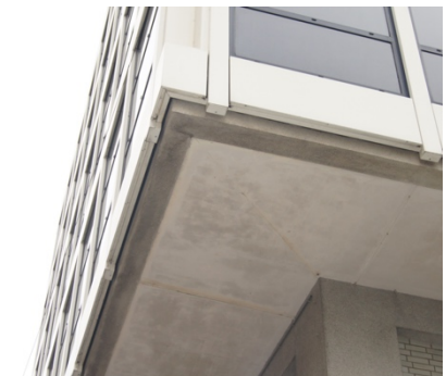
Aansluiting van pui op gevel
