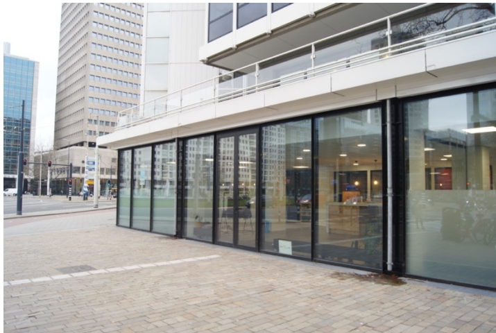
De plint heeft een glazen pui en een met aluminium bekleed betonnen overstek (2018). Daarbovenop staat een witte balustrade (1959).
