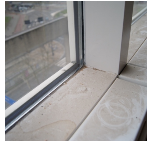
Voor de aluminium kozijnen uit 1987 is op de achtste bouwlaag een borstwering gezet.
