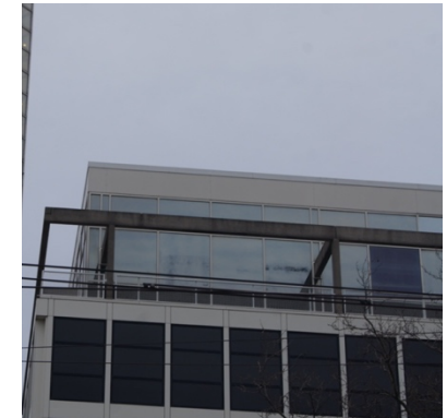
Een betonnen pergola markeert bovenste bouwlagen.
