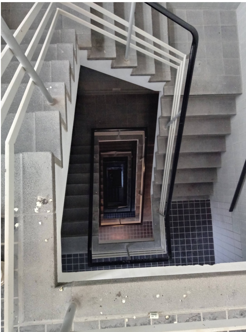
In de hoektrappenhuizen is de oorspronkelijke afwerking aanwezig van betonnen trappen met metalen leuningen, vloeren met zwarte Mosa tegels en wanden met restanten van groene tegels.
