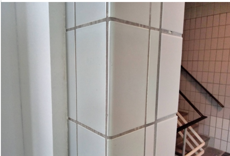
Oorspronkelijke tegelafwerking in het trappenhuis op de linkerhoek, waarbij de oorspronkelijke hoektegels gebogen randjes hebben: een zorgvuldig detail.
