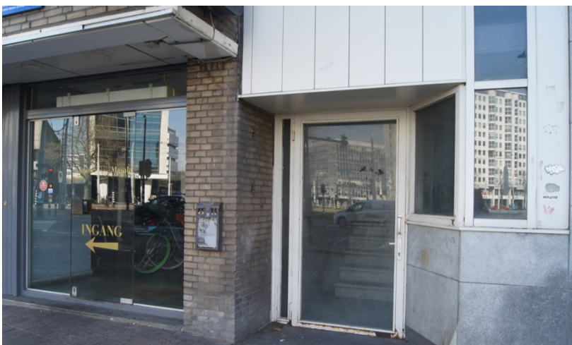
Aansluiting Pompenburgflat en Aegon-flat.
