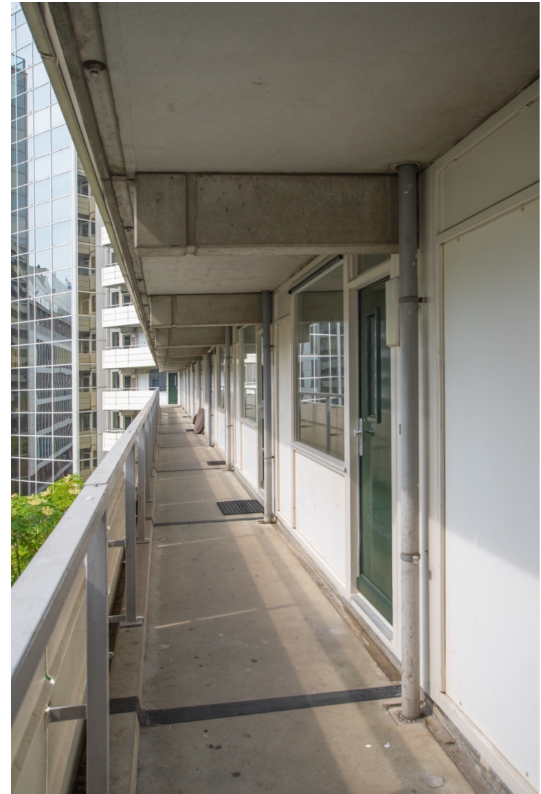
De galerijen met betonskelet in zicht.
