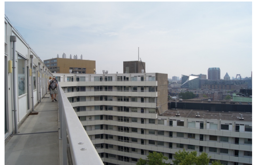
Het gebouw bestaat uit tien en veertien bouwlagen.
