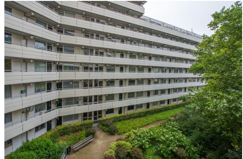
De binnentuin, toegankelijk voor alle bewoners via de trappenhuizen.
