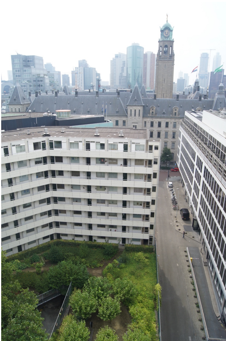
De rijbaan naar de parkeergarage, aan de zijde van het EN-NEN-gebouw (Coolingsingel 6, rechts), voelt als een achterzijde. Doorzicht naar het stadhuis.
