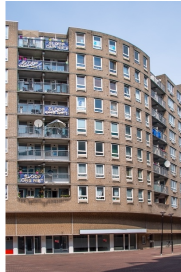
Voorgevel zijde Doelstraat.
