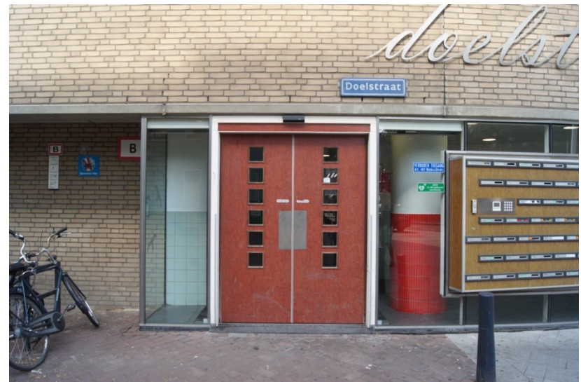
De in 2001 naar voren dichtgezette pui van de entree aan de Doelstraat. Glaspui, deuren en brievenbussen zijn toen gerealiseerd, evenals de bekleding met rode en blauwe tegels in het portaal. 36
