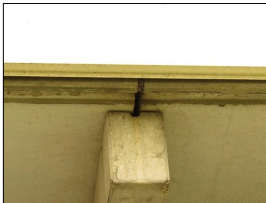
Figuur 4 Open dilatatievoegen.
