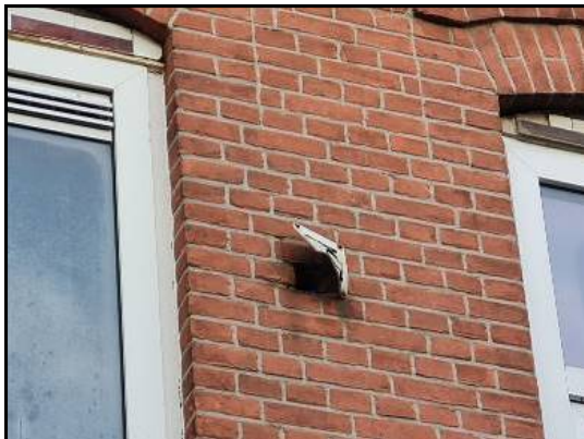
Afbeelding 4: Opening in de muur
