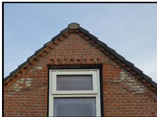
Afbeelding 5: Ruimte achter dakpannen
