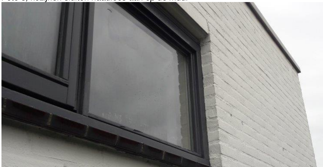
Foto 8, kozijnen sluiten naadloos aan op de muur
