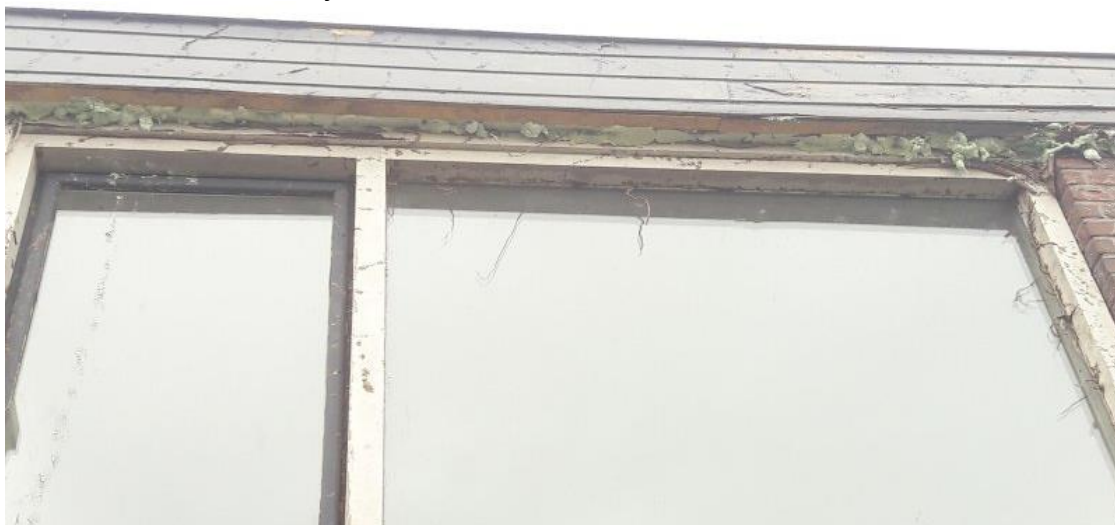
Foto 10, dakrand en kozijnen sluiten naadloos aan
