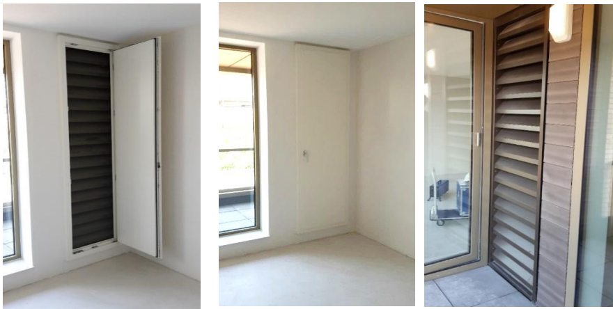
Figuur 4.3 – Impressie Comfortbox; aanzicht binnen open toestand, aanzicht gesloten toestand, aanzicht buiten.
