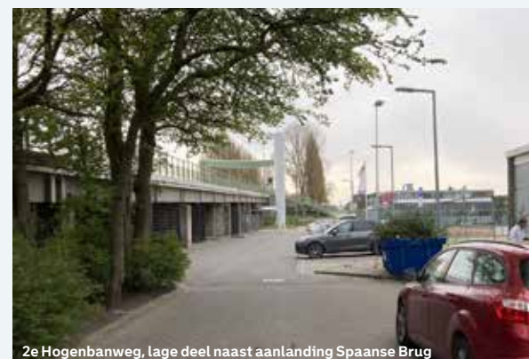
Ze Hogenbanweg, lage deel naast aanlanding Spaanse Brug
