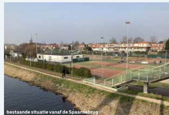
bestaande situatie vanaf de Spaansebrug
